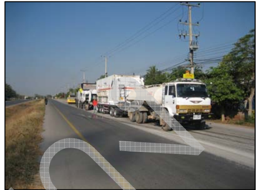
รูปที่ 3-8 การผสมสารผสมเพิ่มแบบ Slurry Mixed (WIRTGEN)
