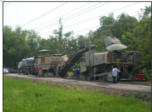
รูปที่ 3-1 เครื่องจักรที่นำมาใช้งาน (Cold Recycling Machines)
