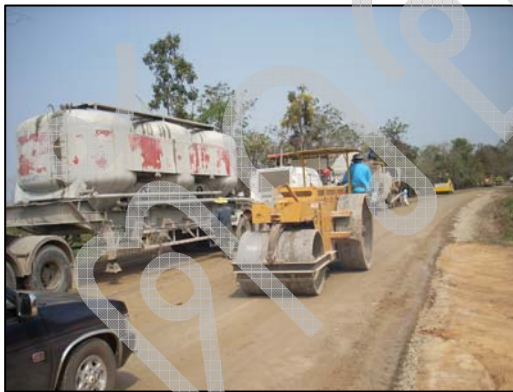
รูปที่ 3-15 เครื่องจักร รถบดล้อเหล็กชนิดล้อเรียบ (Smooth Steel Roller)
