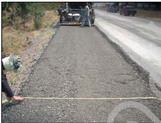
รูปที่ 3-2 การวัดขนาดความกว้างเครื่องขุดตัด
