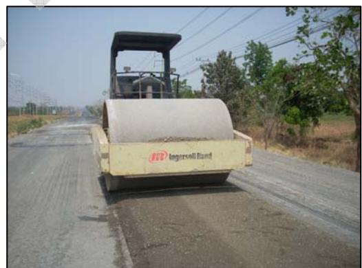
รูปที่ 3-11 เครื่องจักรชุดบดทับ (Compactor) Heavy Vibrating Roller
