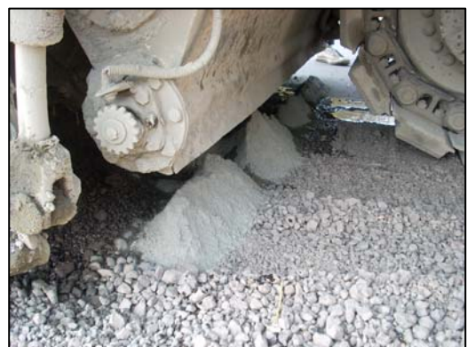
รูปที่ 3-10 การผสมสารผสมเพิ่มแบบโรยปูนผงบนพื้นถนนก่อนขุดผสมและฉีดน้ำ (Cement Powder Spread on Road Surface)
