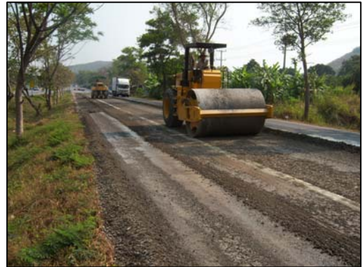
รูปที่ 3-13 เครื่องจักร รถบดล้อเหล็กสันสะเทือนขนาดกลาง (Vibrating Roller : No.2)
