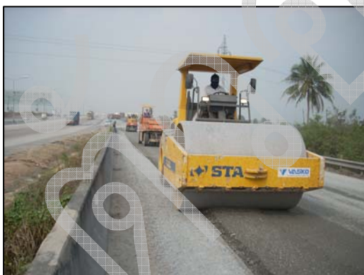
รูปที่ 3-11 เครื่องจักรชุดบดทับ (Compactor) Heavy Vibrating Roller
