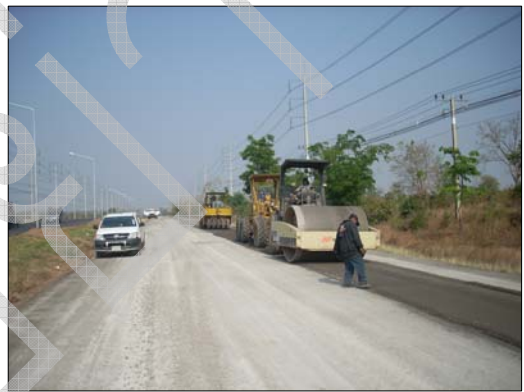
รูปที่ 4-6 เครื่องจักรบดทับ (Rollers)
