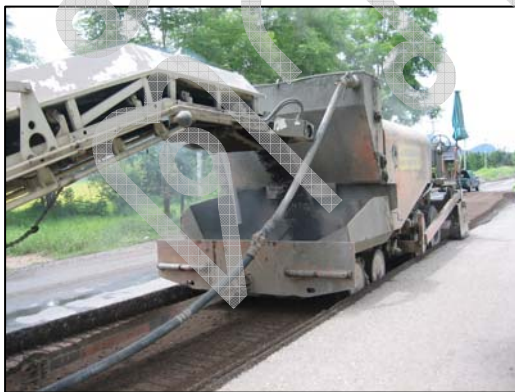
รูปที่ 3-9 การผสมสารผสมเพิ่มแบบ Dry Mixed (MIDLAND)
