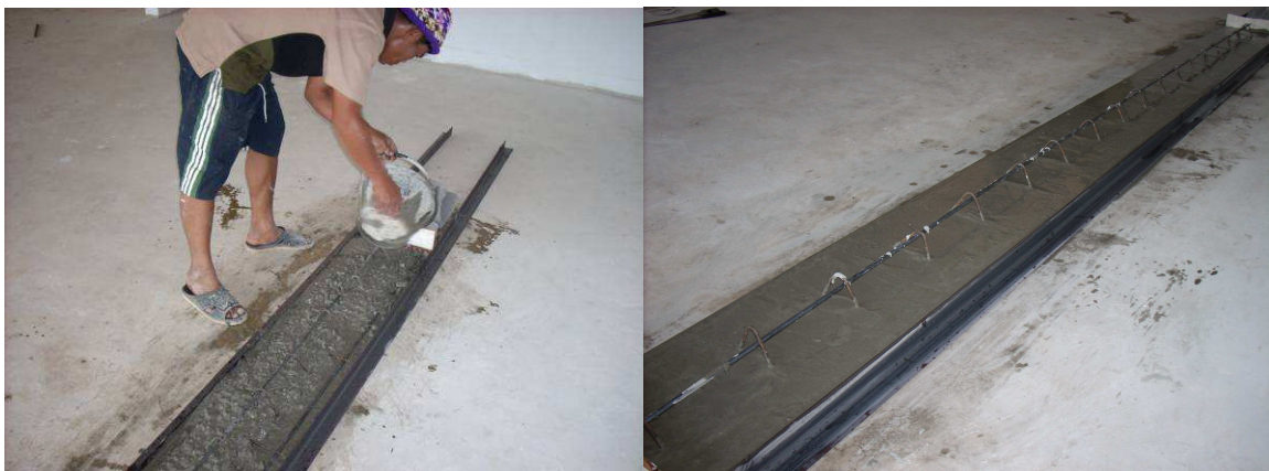
รูปที่ 10 การเทคอนกรีต และคอนกรีตที่ปาดแต่งผิวหน้าแล้ว
