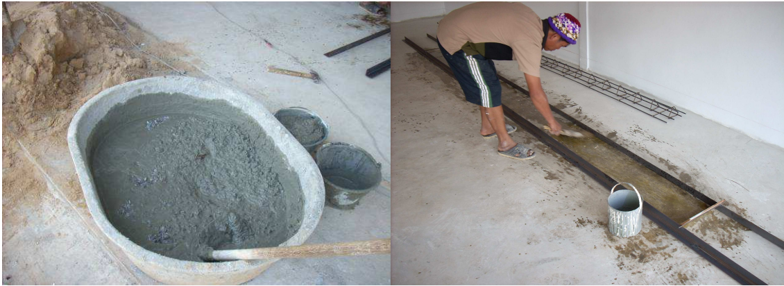
รูปที่ 9 การผสมคอนกรีตโดยใช้การผสมมือ อัตราส่วน 1:2:4 และการทาน้ำมันพื้น (ป้องกันคอนกรีตติดพื้น)
