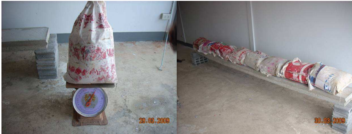
รูปที่ 15 ชั่งน้ำหนักถุงทราย (300 kg/m 2 ) และนำไปวางบนแผ่นพื้นฯ ค้างน้ำหนักไว้ 24 ชม.
