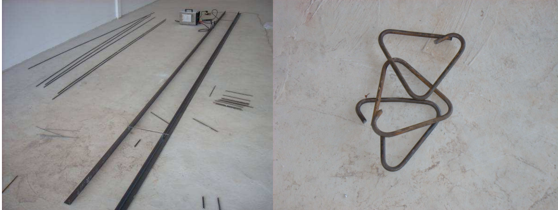
รูปที่ 7 การเตรียมวัสดุ เหล็กเสริม แบบหล่อ และเหล็กปลอก
