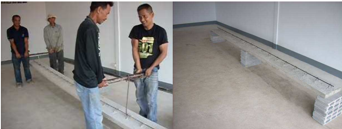
รูปที่ 12 แสดงการยกแผ่นพื้นสำเร็จรูป และนำมาวางที่ตำแหน่งที่เตรียมไว้
