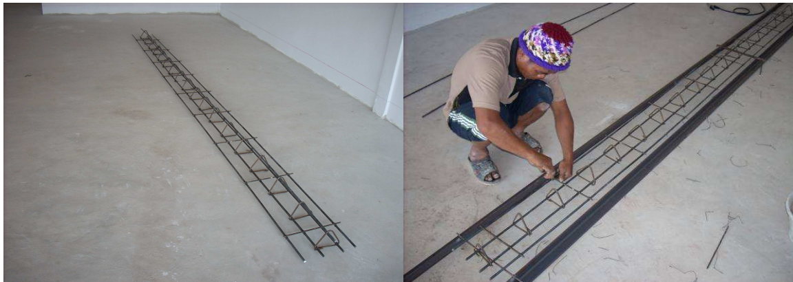
รูปที่ 8 เหล็กเสริมที่สมบูรณ์และ นำมาเข้าแบบหล่อ
