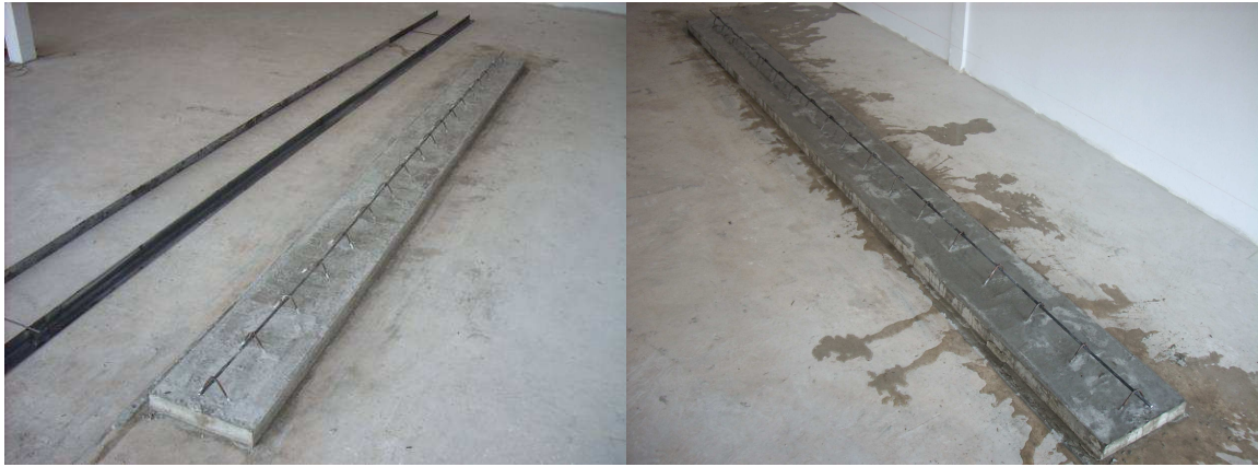
รูปที่ 11 คอนกรีตที่แข็งตัวแล้ว ถอดแบบหล่อ และปมชื้น โดยการใช้ น้ำ
