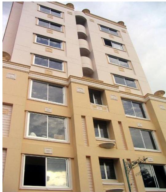
ภายหลังการติดตั้งวัสดุ GRC
