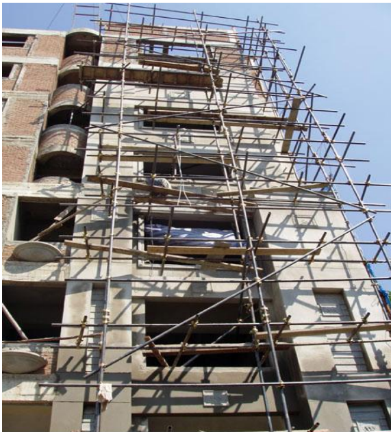
ก่อนการติดตั้งวัสดุ GRC
