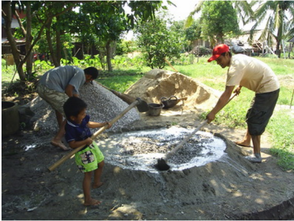
การผสมด้วยเครื่องมือ แรงงานคน
