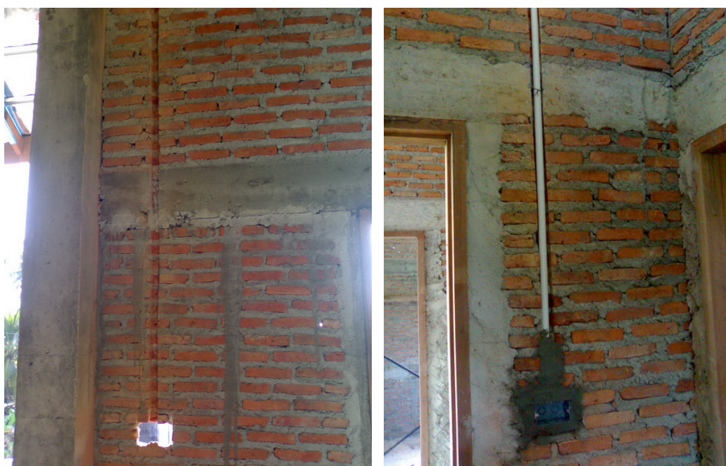
การเจาะผนังเพื่อวางตำแหน่งท่อร้อยสายไฟ
