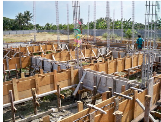
แบบหล่อคอนกรีตชนิดประกอบกับที่
