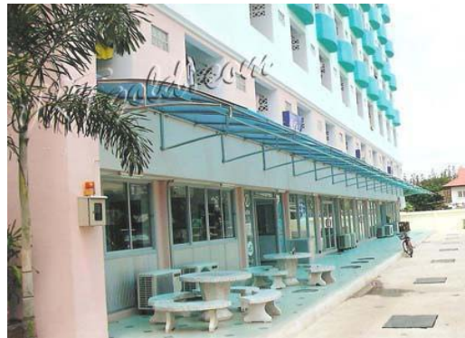
การนำวัสดุผนังหลังคาโพลีคาร์บอเนตไปใช้งานผนังหลังคาซุ้มทางเข้าบ้าน กันสาด ฯลฯ
