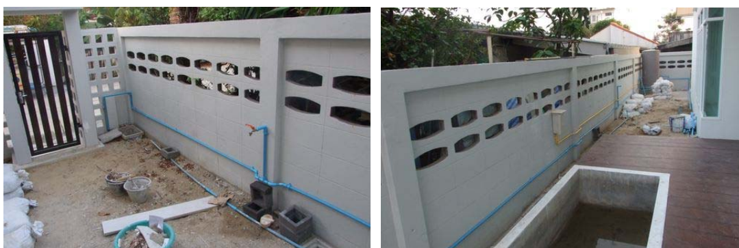
รูปที่ 3.24 การเดินลอยท่อน้ำใช้
