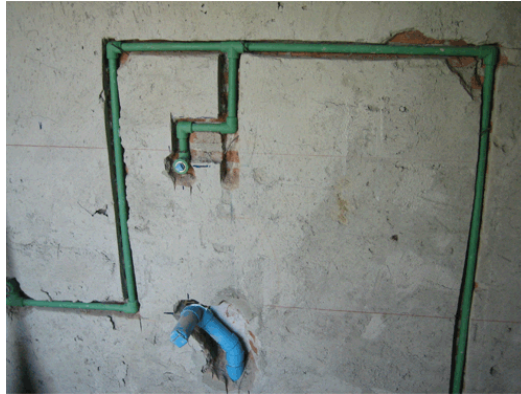
รูปที่ 3.25 การเดินท่อน้ำใช้ฝังในผนัง
