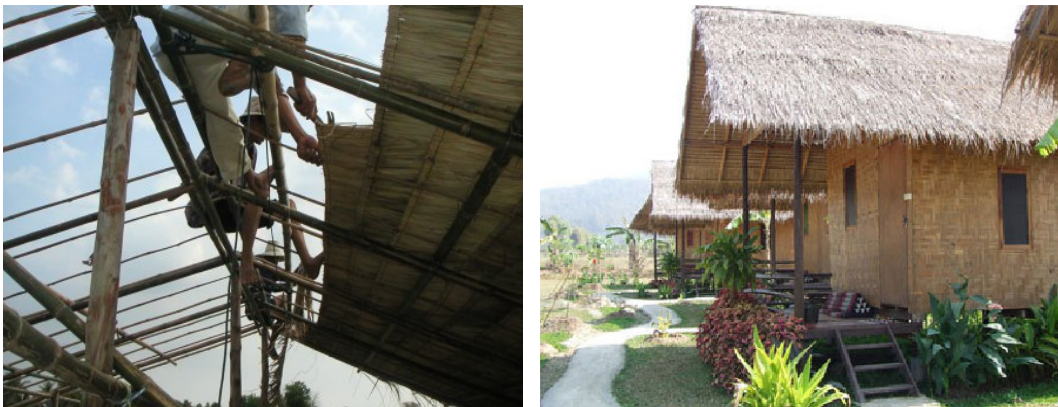
รูปที่ 1.124 หลังคาแฝกหรือหญ้าคา
