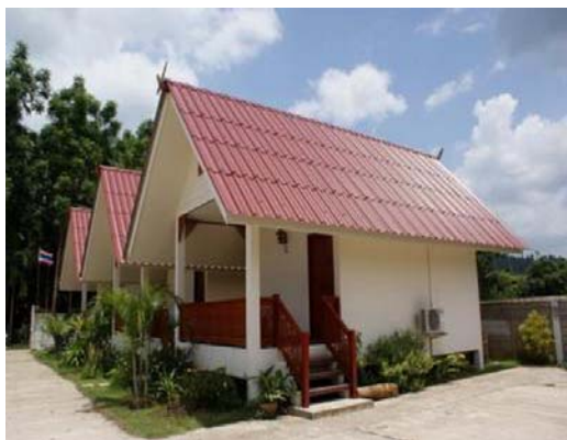
การนำกระเบื้องใยหินแผ่นลอนไปใช้มุงหลังคาบ้านพักอาศัย โรงเก็บของ อาคารอเนกประสงค์ ฯลฯ
