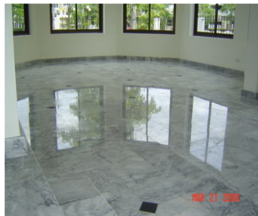
การปูพื้นหินแกรนิตและหินอ่อนภายในอาคาร รูปที่ 1.88(ต่อ) การนำวัสดุปูพื้นชนิดต่างๆไปใช้งาน ที่มา: www.market.mthai.com
