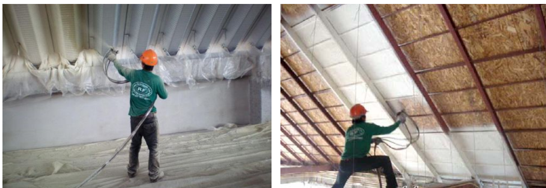
รูปที่ 1.130 งานที่ใช้ฉนวนกันความร้อนโพลียูรีเทนโฟม
