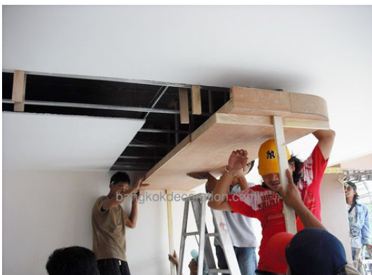
รูปที่ 1.102 การนำไม้อัดแผ่นเรียบบางไปใช้งาน
