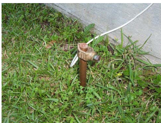
รูปที่ 3.11 หลักรดิน
