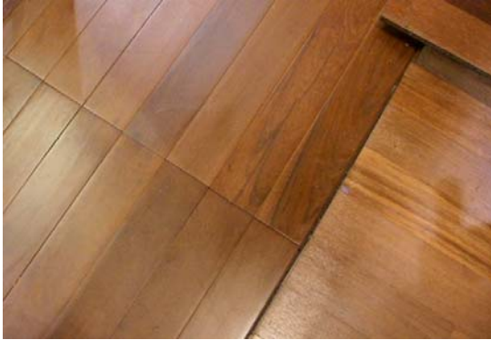
พื้นไม้เต็ง
