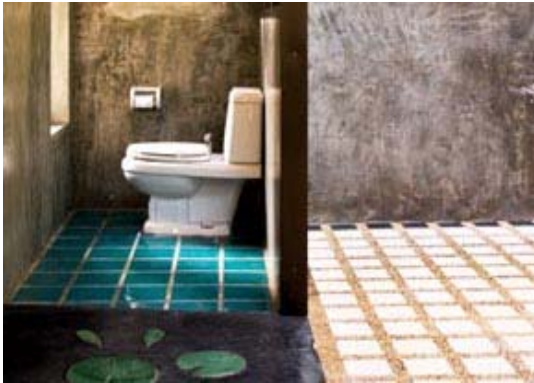
การนำกระเบื้องเคลือบไปใช้ปูพื้นห้องน้ำและตกแต่งผิวพื้นทางเดินด้านนอกอาคาร
