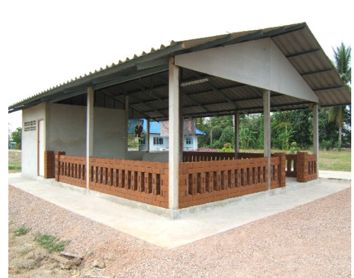
การนำกระเบื้องใยหินแผ่นลอนไปใช้มุงหลังคาบ้านพักอาศัย โรงเก็บของ อาคารอเนกประสงค์ ฯลฯ
