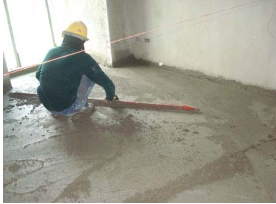
งานพื้นคอนกรีต
