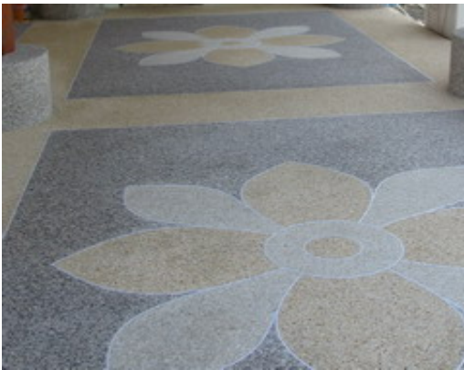
การปูพื้นกรวดล้างนิยมใช้เป็นพื้นภายนอกอาคาร ถนน ทางเดิน ฯลฯ
