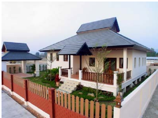
การนำกระเบื้องคอนกรีตแผ่นเรียบไปใช้ในงานมุงหลังคาบ้านพักอาศัย โรงเรียน หมู่บ้านจัดสรร ฯลฯ
