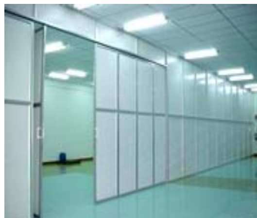
รูปที่ 1.110 การนำแผ่นพลาสวูดไปใช้งาน
