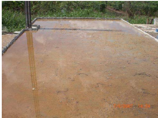
การขังน้ำบ่มคอนกรีต
