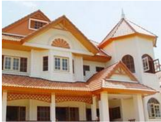
การนำกระเบื้องคอนกรีตไปใช้ในงานมุงหลังคาประเภทบ้านพักอาศัยทั่วไป
