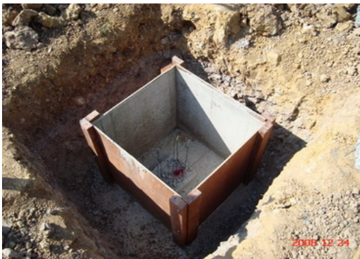
แบบหล่อคอนกรีตไม้กะบาก
