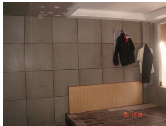
รูปที่ 1.109 การนำแผ่นวีว่าบอร์ดไปใช้งาน ที่มา: www.chinno.net
