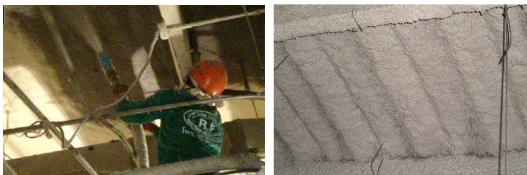
รูปที่ 1.36 งานที่ใช้ฉนวนกันความร้อนใยเซลลูโลส
