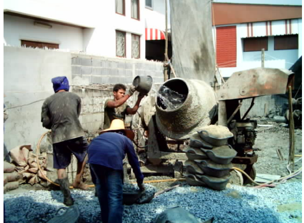
การผสมด้วยเครื่องมือผสมคอนกรีตขนาดเล็ก
