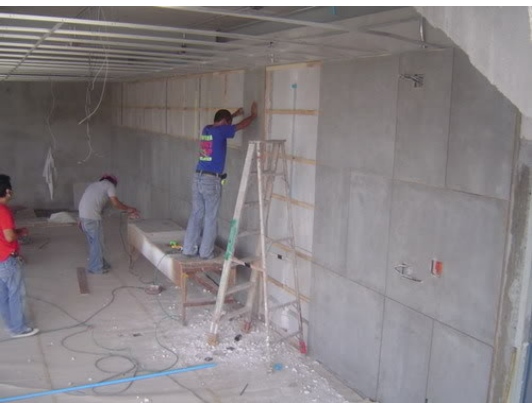
รูปที่ 1.109 การนำแผ่นวีว่าบอร์ดไปใช้งาน ที่มา: www.chinno.net
