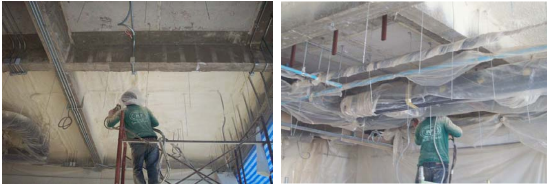
รูปที่ 1.137 งานที่ใช้ฉนวนกันความร้อนใยแร่
