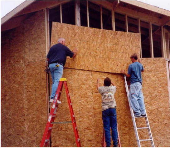
รูปที่ 1.105 การนำแผ่นเซฟวิ่งบอร์ดไปใช้งาน ที่มา: www.buildingtalk.com
