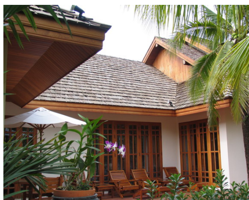
การนำวัสดุผนังหลังคาไม้ซี้ดาร์ไปใช้งานผนังหลังคา บ้านพักตากอากาศ โรงแรม สปา รีสอร์ท ฯลฯ
