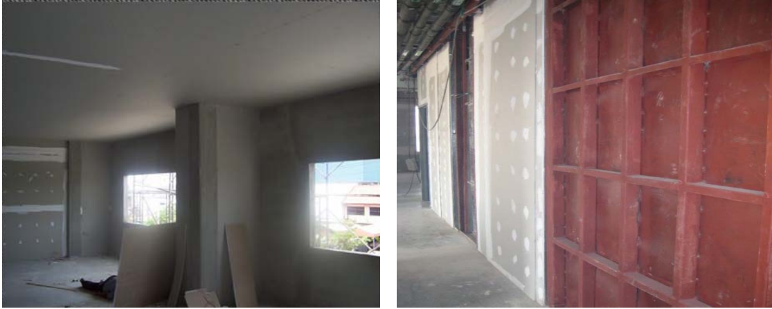
รูปที่ 1.107 การนำแผ่นยิปซัมบอร์ดไปใช้งาน ที่มา: www.cellocretethai.com
