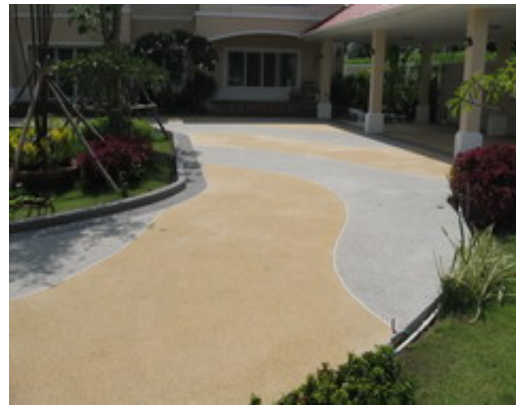
การปูพื้นกรวดล้างนิยมใช้เป็นพื้นภายนอกอาคาร ถนน ทางเดิน ฯลฯ
