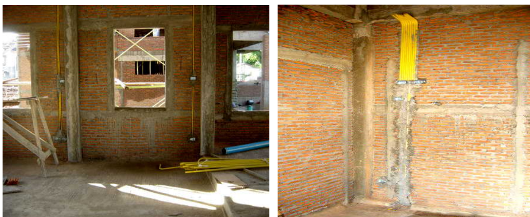
รูปที่ 3.2 การเดินสายไฟแบบปิด แบบซ่อนสายในท่อ
