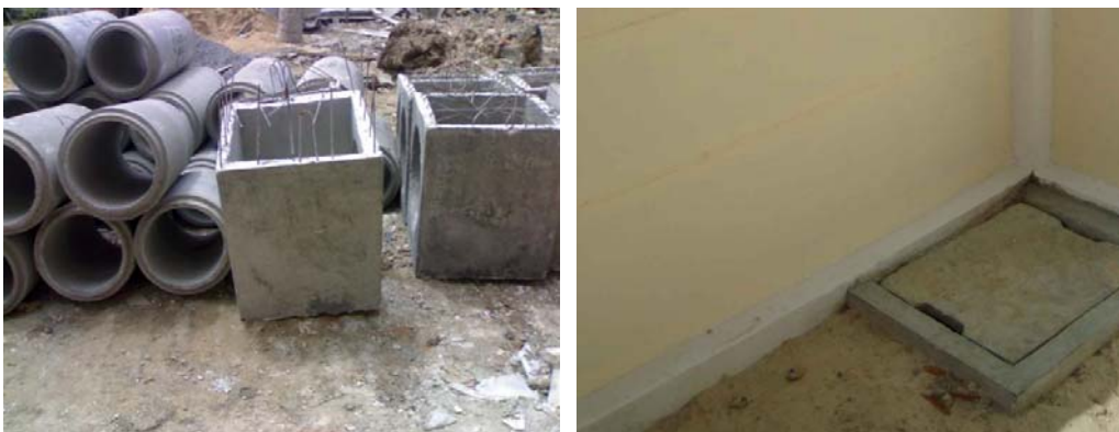
รูปที่ 3.44 บ่อตรวจระบายน้ำ
