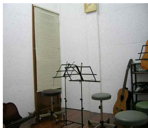
รูปที่ 1.111 การนำแผ่นแอคูสติคบอร์ดไปใช้งาน
