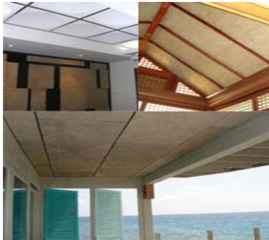
รูปที่ 1.106 การนำแผ่นเซลโลกรีทไปใช้งาน ที่มา: www.cellocretethai.com
