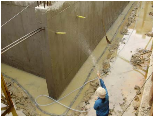
การฉีคน้ำบ่มคอนกรีต
