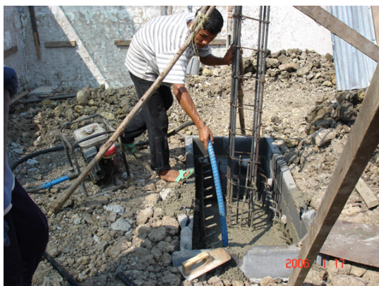
รูปที่ 1.47 การเทคอนกรีตและการเขย่าคอนกรีต
