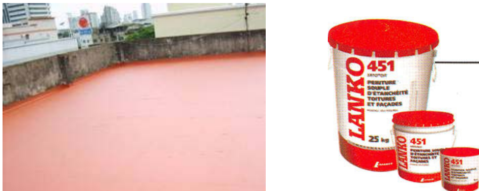
รูปที่ 1.140 การนำLanko 451 ทาพื้นดาดฟ้า
