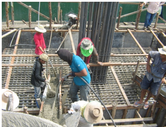
รูปที่ 2.15 การใช้งานของเครื่องเขย่าคอนกรีต
