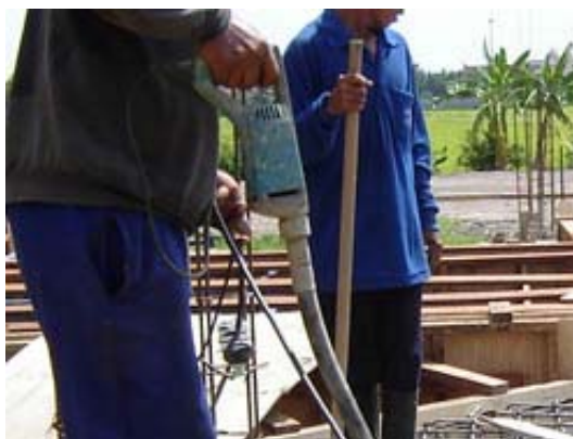
รูปที่ 1.47 การเทคอนกรีตและการเขย่าคอนกรีต
