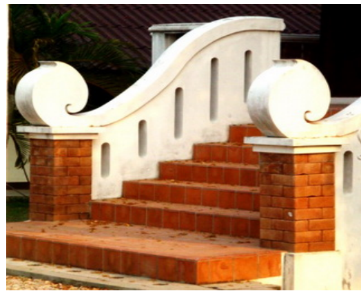
การนำกระเบื้องดินเผาไปใช้ปูพื้นภายในและตกแต่งผิวพื้นบันไดด้านนอกอาคาร
