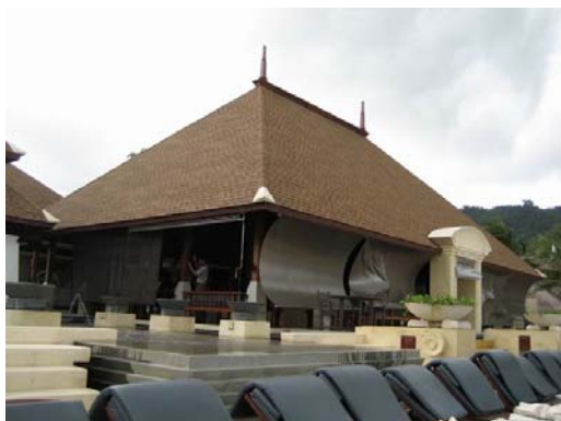
การนำวัสดุผนังหลังคาแอสฟัลต์ซิงเกิ้ลไปใช้งานผนังหลังคาบ้านพักอาศัย โรงแรม บ้านพักตากอากาศ ฯลฯ
