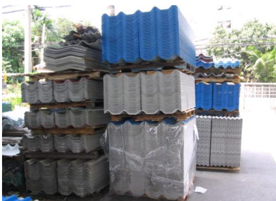
รูปที่ 1.125 การกองวัสดุผนังหลังคาก่อนนำไปใช้งาน
