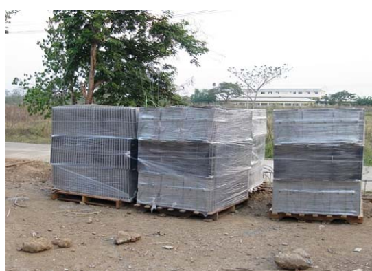
รูปที่ 1.125 การกองวัสดุผนังหลังคาก่อนนำไปใช้งาน
