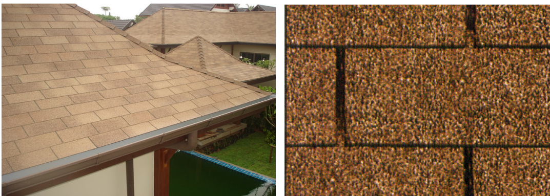
รูปที่ 1.121 วัสดุผนังหลังคาแผ่นซิงเกิ้ลรูฟ
