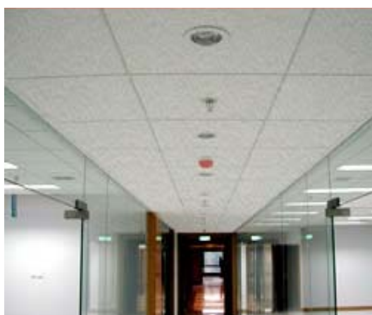
รูปที่ 1.111 การนำแผ่นแอคูสติคบอร์ดไปใช้งาน
