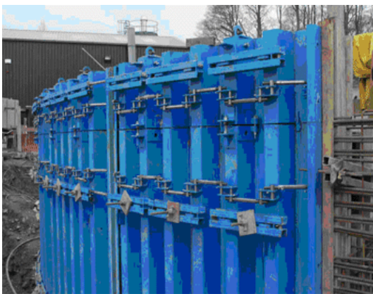
แบบหล่อคอนกรีตสำเร็จรูป
