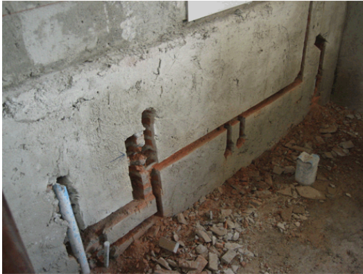
รูปที่ 3.25 การเดินท่อน้ำใช้ฝังในผนัง
