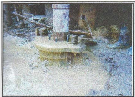
เทคอนกรีตใส่สารละลายเบนโทไนท์
