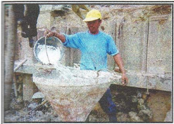
ใส่ไฟมก่อนเทคอนกรีต
