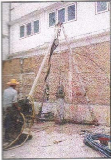
ลงปลอกเหล็ก (Casing)
