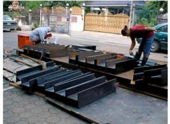
- รูปที่ 9 เสาเข็มเหล็ก H-Beam -
