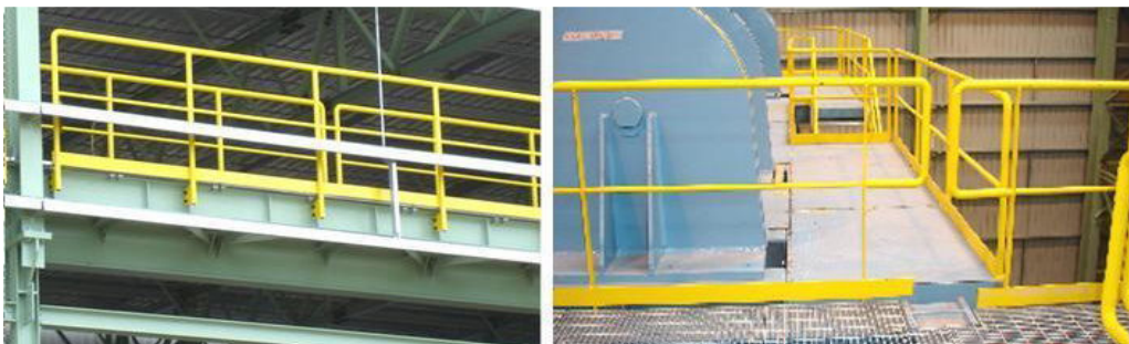
Platform ถาวรต้องประกอบด้วยรั้วบน-รั้วกลาง-และแผ่นกันของตก
