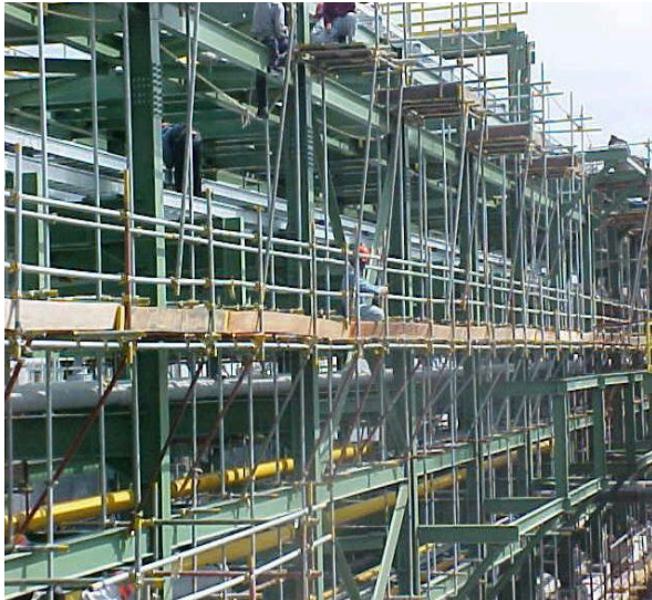
ซ้าย : นั่งร้านแบบยกพื้นค้ำยัน
