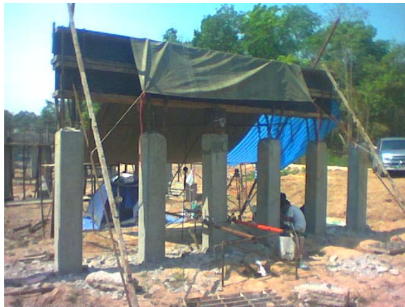
รูปที่ 3.15 การทดสอบเข็มโดยกดเสาเข็มลงในแนวดิ่ง
