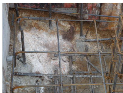
รูปที่ 14 สภาพของการเสริมความยึดรั้งในฐานรากกับพื้นหิน
