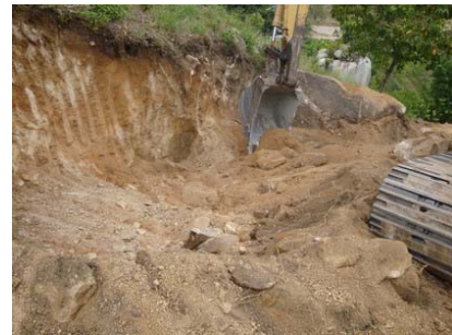
รูปที่ 22 การขุดเอาก้อนหินที่ไม่ต้องการ ข้ายออกไปนอกพื้นที่
