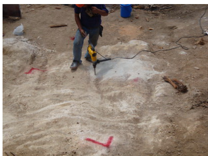
รูปที่ 9 การเจาะหินให้ได้รูที่มีขนาดและความลึกตามต้องการ
