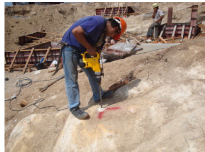
รูปที่ 8 การเจาะหินให้ได้รูที่มีขนาดและความลึกตามต้องการ
