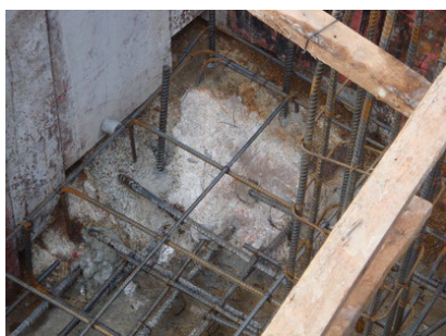
รูปที่ 15 สภาพของการเสริมความยึดรั้งในฐานรากกับพื้นหิน
