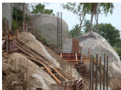
รูปที่ 17 การประกอบไม้แบบและเสริมเหล็กของฐานราก
