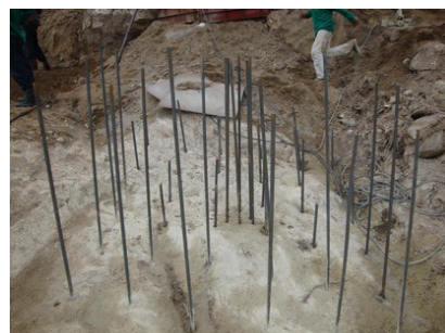
รูปที่ 10 การเสียบเหล็กฝังลงไปในพื้นที่ที่กำหนดไว้
