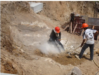
รูปที่ 21 การสกัดเอาหินที่ไม่ต้องการบางส่วนออกไป
