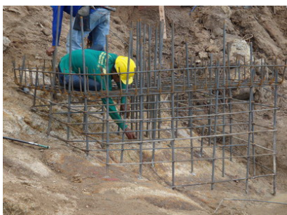
รูปที่ 13 การใช้ลวดผูกเหล็กเสริมให้แน่นหนา
