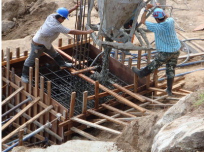
รูปที่ 19 การเทคอนกรีตลงในฐานราก
