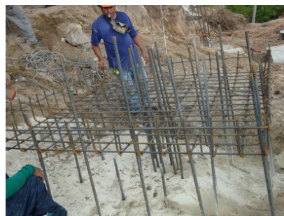
รูปที่ 12 การวางเหล็กเสริมของฐานรากแผ่ตามแบบก่อสร้าง
