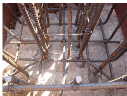
รูปที่ 16 สภาพของการเสริมความยึดรั้งในฐานรากกับพื้นหิน
