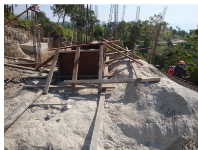
รูปที่ 18 สภาพไม้แบบและเหล็กเสริมที่พร้อมจะเทคอนกรีต
