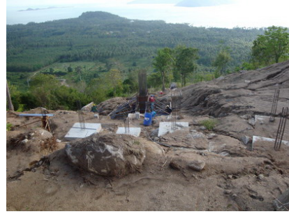
รูปที่ 20 ฐานรากที่ได้เทคอนกรีตและถอดไม้แบบออกแล้ว
