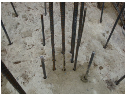
รูปที่ 11 Epoxy-Tieจะลื่นออกมาให้เห็นเมื่อเสียบเหล็กเส้นเข้าไป
