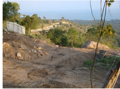
รูปที่ 6 ภาพเส้นทางรถขนส่งขึ้นมายังบริเวณที่ตั้งอาคาร
