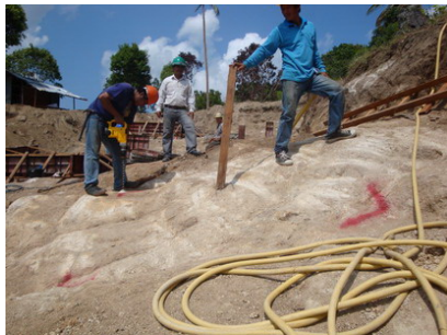
รูปที่ 7 การวางตำแหน่งฐานรากแผ่นบนพื้นหิน
