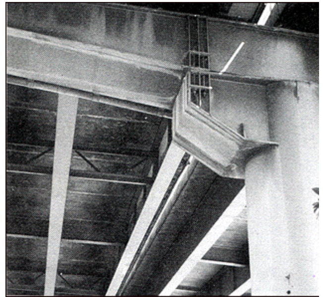
รูปที่ 2 แผ่นพื้นคอนกรีตสำเร็จรูปวางบนโครงเหล็ก
