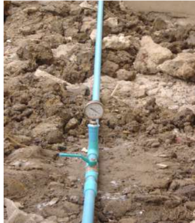
รูปที่ 5.4 ทดสอบที่ความดันประมาณ 7 bar (100 psi) ทิ้งไว้ 6 ชั่วโมง โดยที่ค่าความดันต้องไม่เปลี่ยนแปลง
