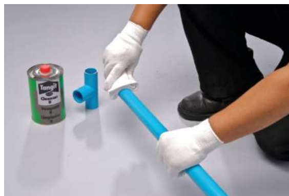
รูปที่ 4.9 แสดงการทำความสะอาดท่อพีวีซีด้วยน้ำยาทำความสะอาด (ที่มา : ท่อเอสซีจี)
