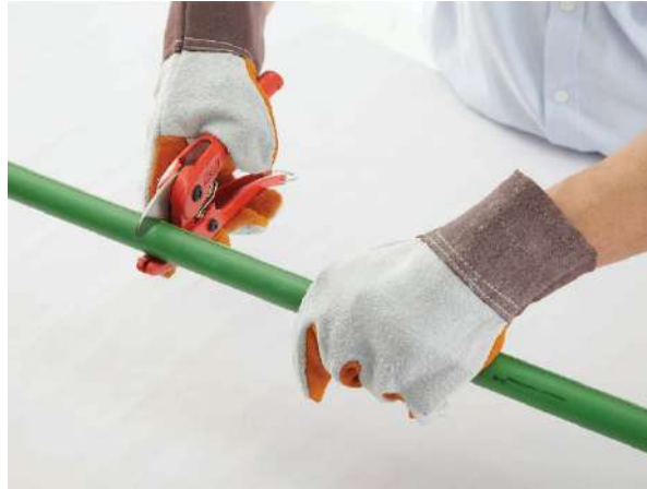
รูปที่ 4.20 แสดงการตัดท่อพีพีอาร์ด้วยกรรไกรตัดท่อ (ที่มา : ท่อเอสซีจี)
