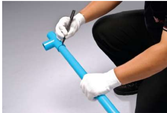
รูปที่ 4.8 แสดงการทำเครื่องหมายที่ปลายท่อพีวีซีหลังการวัดระยะสวม (ที่มา : ท่อเอสซีจี)
