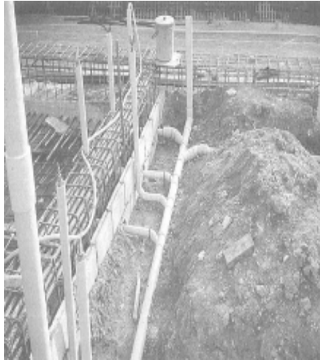
รูปที่ 5.5 ภาพแสดงการทดสอบท่อระบายน้ำด้วยแรงดันน้ำ
