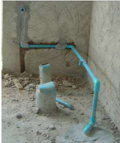
รูปที่ 5.2 ครอบคลุมท่อทุกจุดที่น้ำออกได้ ยกเว้นบริเวณด้านท้ายหรือจุดสุดท้ายของท่อ
