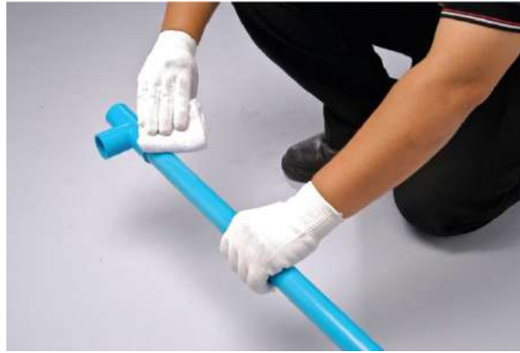
รูปที่ 4.12 แสดงการเช็ดน้ำยาส่วนเกินบริเวณรอยต่อท่อ (ที่มา : ท่อเอสซีจี)
