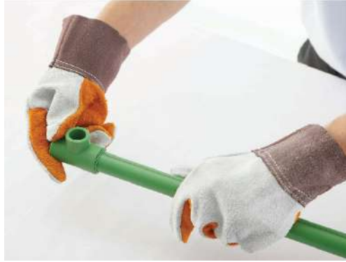
รูปที่ 4.23 แสดงการเชื่อมท่อและข้อต่อพีพีอาร์หลังการใช้ความร้อน (ที่มา : ท่อเอสซีจี)
