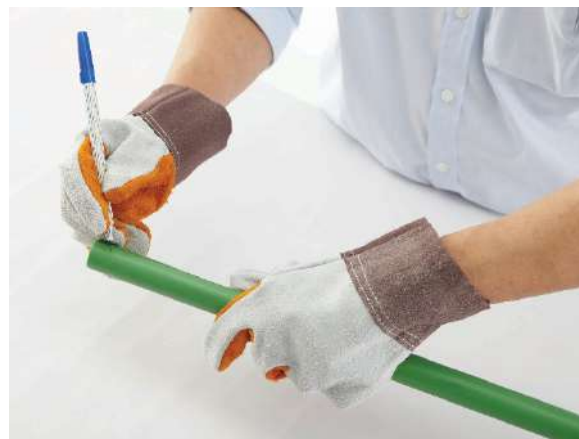
รูปที่ 4.21 แสดงการวัดระยะความลึกและทำเครื่องหมายบนท่อ (ที่มา : ท่อเอสซีจี)
