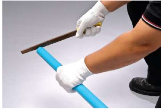
รูปที่ 4.7 แสดงการใช้ตะไบลบมุมที่ปลายท่อพีวีซี (ที่มา : ท่อเอสซีจี)
