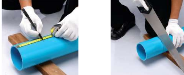
รูปที่ 4.13 แสดงการวัดระยะและตัดท่อแหวนยาง (ที่มา : ท่อเอสซีจี)
