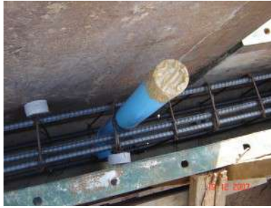
รูปที่ 4.1 การวาง Sleeve ด้วยท่อพีวีซี ก่อนการเทคอนกรีต
