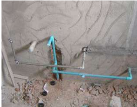
รูปที่ 5.1 ตรวจสอบจุดยึดครั้งต่างๆ ให้เรียบร้อย และตรวจสอบแนว เส้นท่อให้เป็นไปตามแบบ
