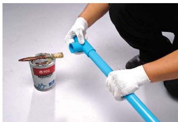
รูปที่ 4.11 แสดงการสวมท่อและข้อต่อพีวีซีเข้าด้วยกันหลังจากทาน้ำยาประสานท่อ (ที่มา :ท่อเอสซีจี)
