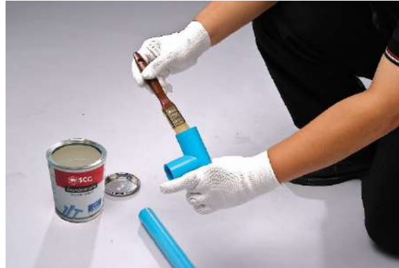
รูปที่ 4.10 แสดงการทาน้ำยาประสานท่อ (ที่มา :ท่อเอสซีจี)
