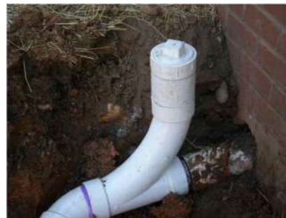
รูปที่ 4.99 การติดตั้งช่องล้างท่อ
