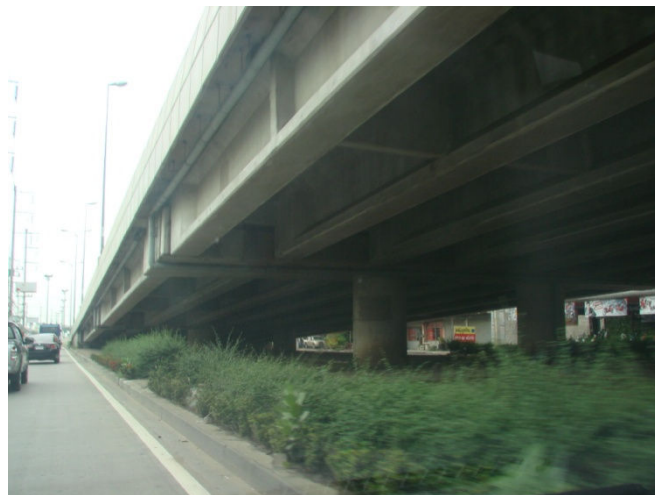
รูปที่ 1.19 ท่อ Drain Pipe ประเภท PVC ที่ไม่ควรใช้ ในสะพาน
