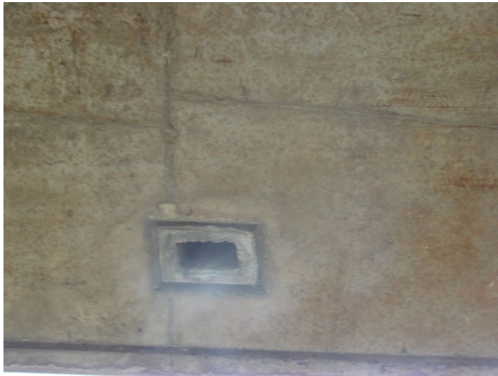
รูปที่ 1.7 แสดง Mortar Pipe ในสะพานประเภท Slab Type
