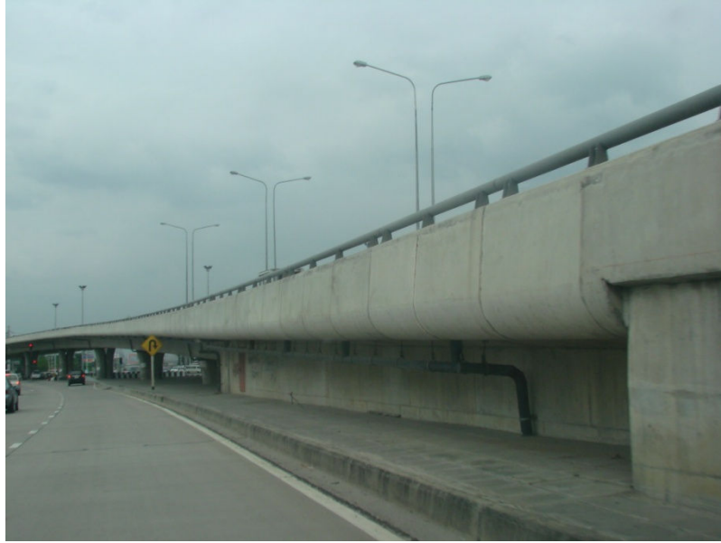
รูปที่ 1.22 ท่อ HDPE เพื่อใช้สำหรับระบบระบายน้ำจากบนสะพานในสะพานประเภท Box Girders
