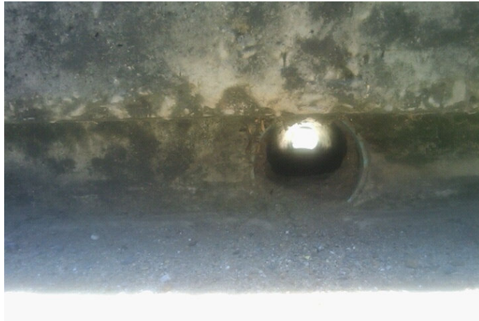
รูปที่ 1.12 แสดงท่อ PVC ในสะพานประเภท Box Beam
