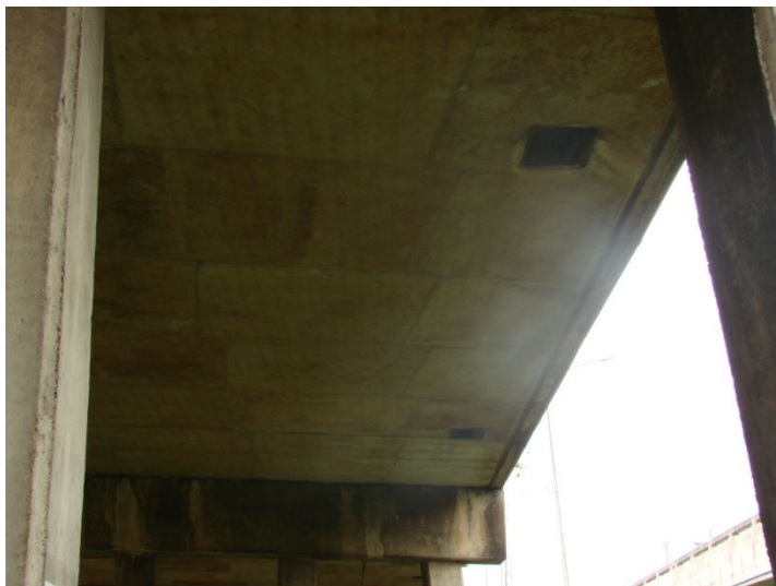
รูปที่ 1.8 แสดง Mortar Pipe ในสะพานประเภท Slab Type
