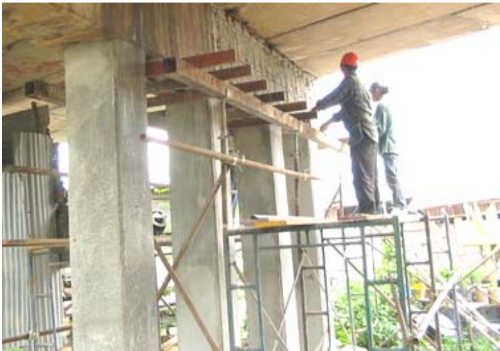
รูปที่ ข.17 (ข) ลักษณะค้ำยันเหล็ก
