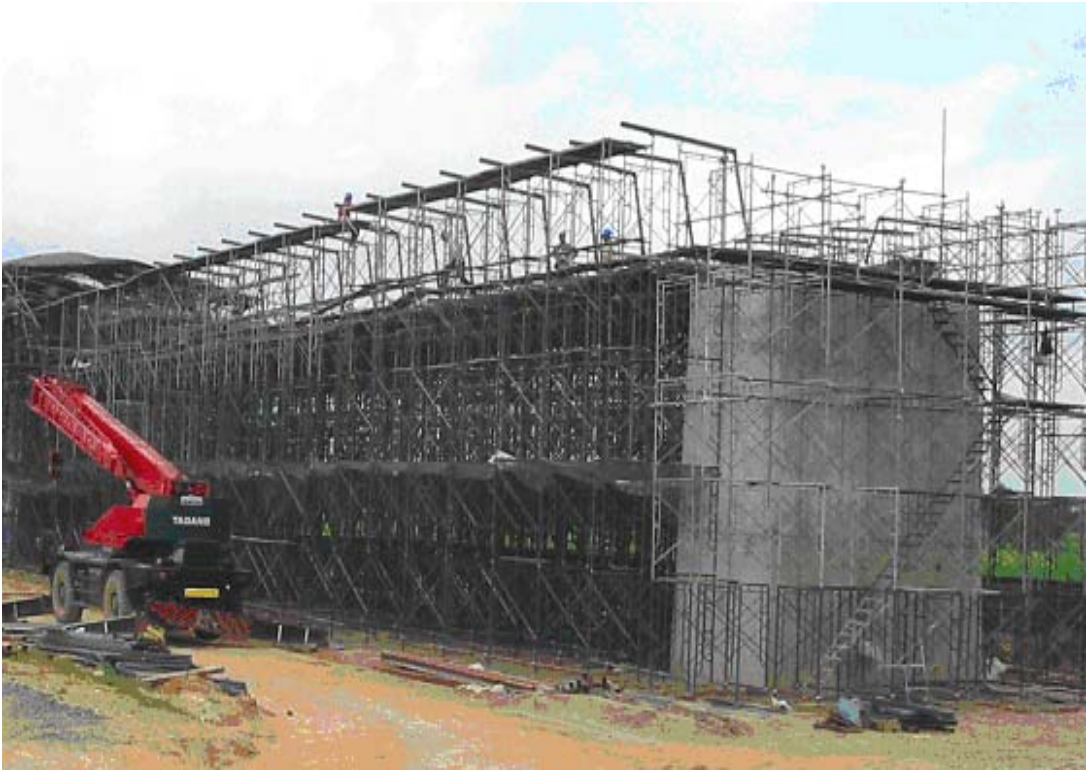
รูปที่ ข.17 (ค) การใช้นั่งร้านเหล็ก
