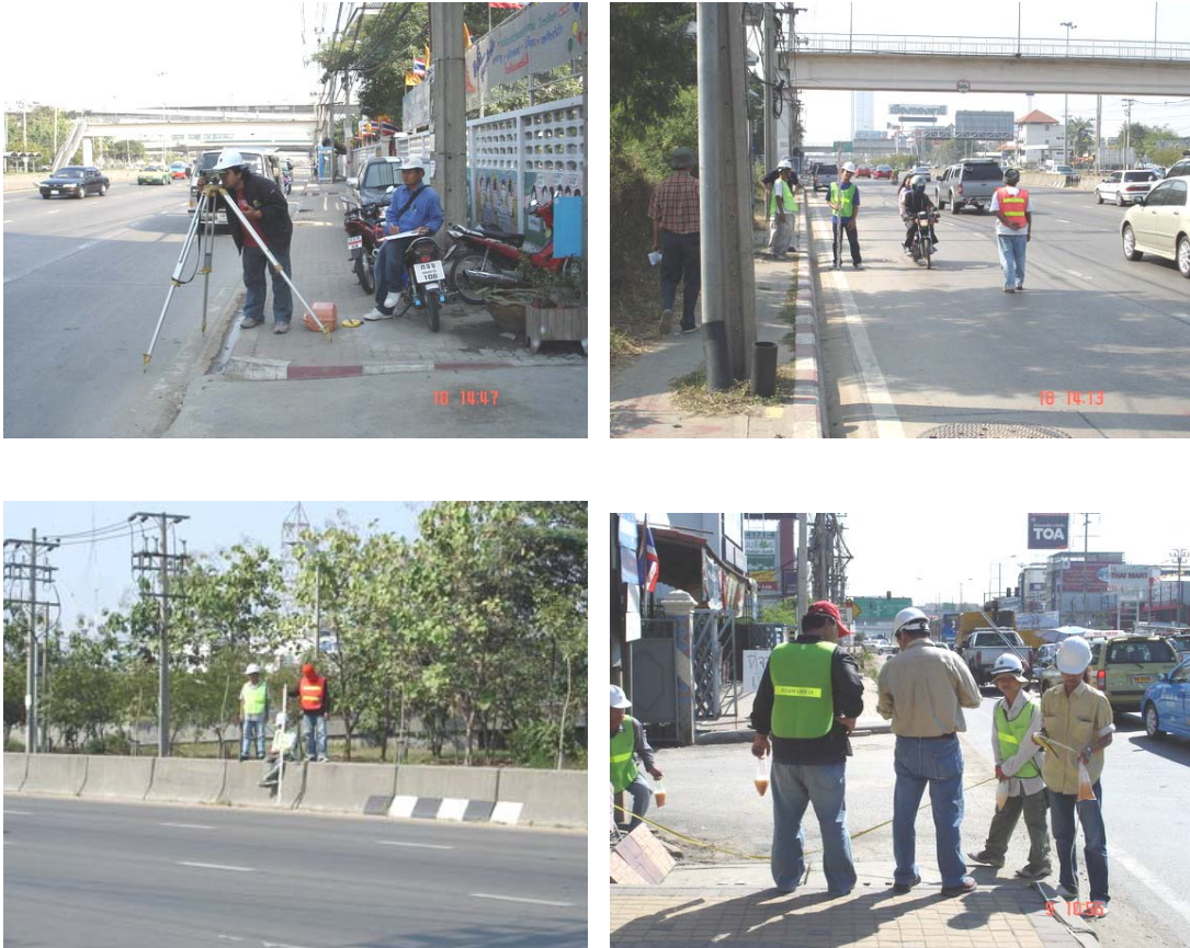
รูปที่ 2.4 การเก็บค่าระดับเพื่อจัดทำรูปตัดสภาพคันทางเดิม (Existing Cross Section)
