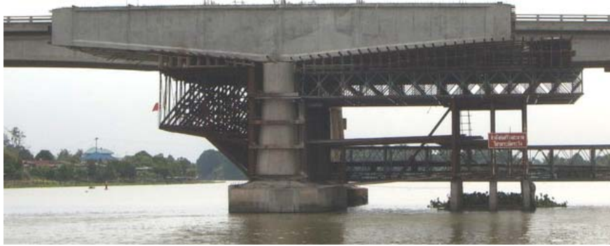
รูปที่ ข.13 แบบหล่อสะพานยื่นที่ใช้แบบเหล็ก
