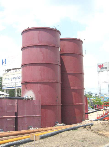
รูปที่ 5.7 ถังเก็บของเหลว พวยงเสถียรภาพหลุมเจาะ
