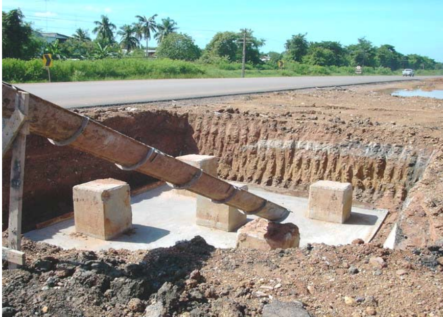
รูปที่ ค.4 การลำเลียงคอนกรีตโดยใช้ราง
