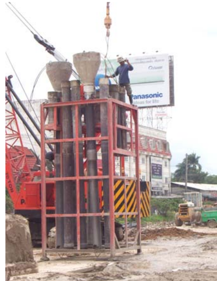
รูปที่ 5.10 ท่อสำหรับเทคอนกรีต (Tremie Pipe)
