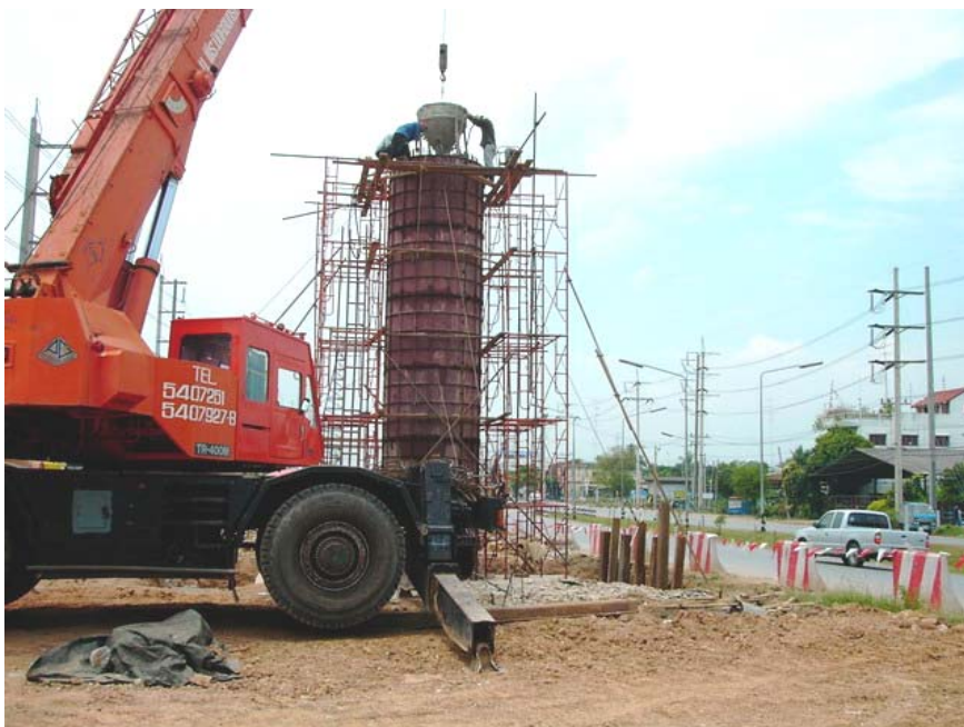
รูปที่ ค.5 การลำเลียงคอนกรีตโดยใช้เครน
