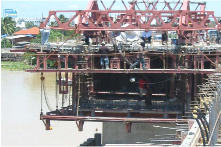
รูปที่ ข.11 แบบหล่อและนั่งร้านทำงาน
