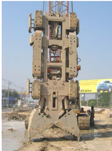
รูปที่ 5.1 เครื่องจักรขุดดินสำหรับก่อสร้างผนังพีคแบบ Cable Hang Grab
