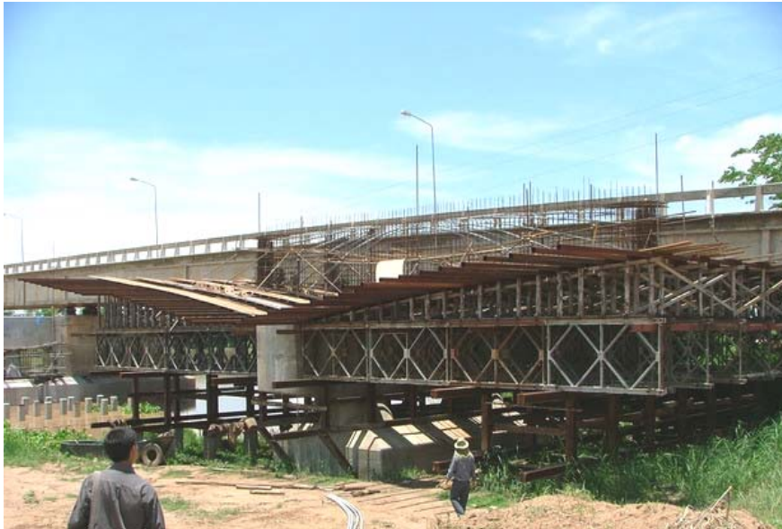
รูปที่ ข.14 แบบหล่อสะพานยื่นที่ใช้แบบไม้
