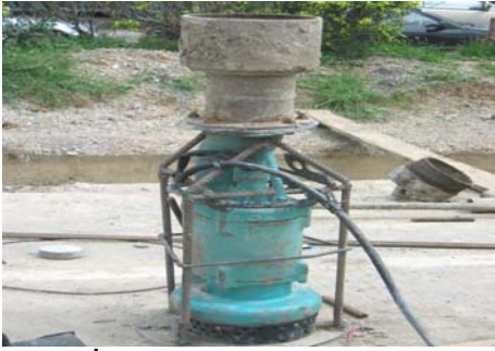
รูปที่ 5.4 เครื่องสูบของเหลวพยางเสถียรภาพออกจากหลุมเจาะขนาดเส้นผ่านศูนย์กลางท่อ 8"
