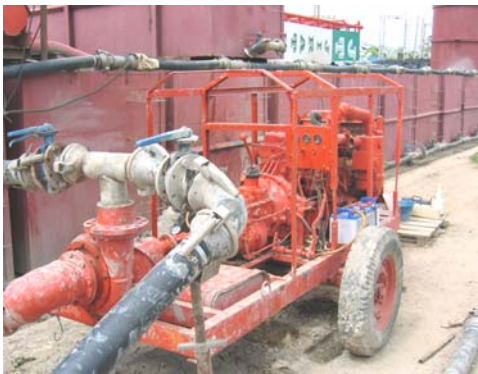
รูปที่ 5.5 เครื่องสูบของเหลวพยางเสถียรภาพเข้าไปในหลุมเจาะขนาดเส้นผ่านศูนย์กลางท่อ 4"
