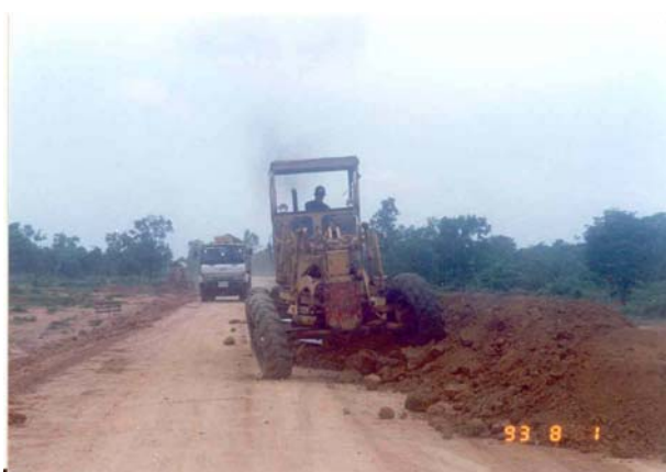
งาน Earth Embankment
