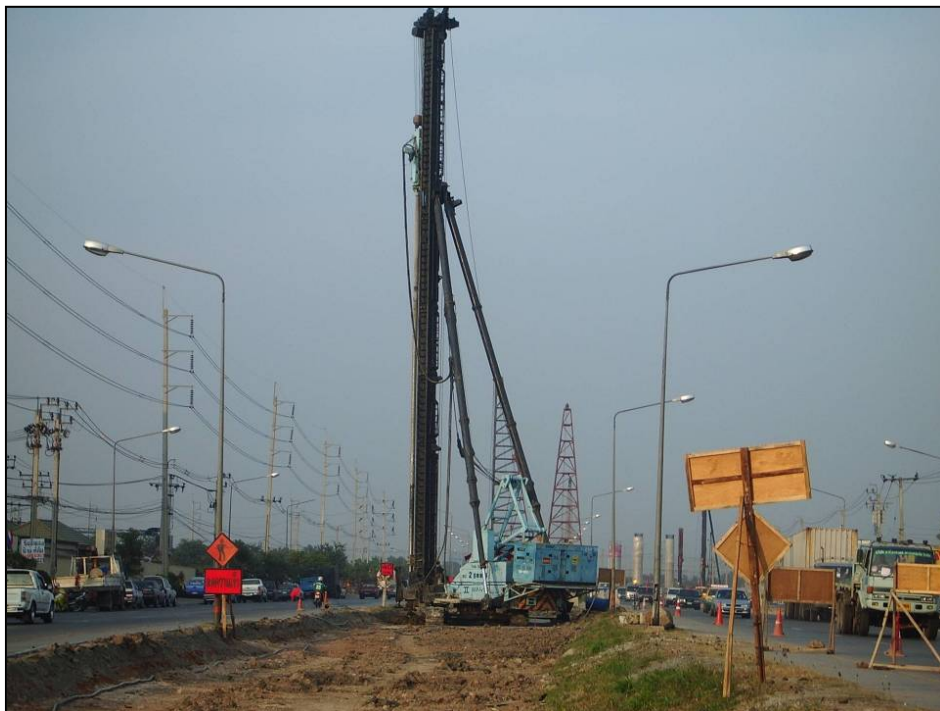
ภาพแสดงลักษณะของเครื่องจักรระบบ Wet Mixing
