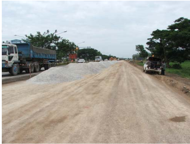
การลงหินคลุกบนชั้นรองพื้นทาง
