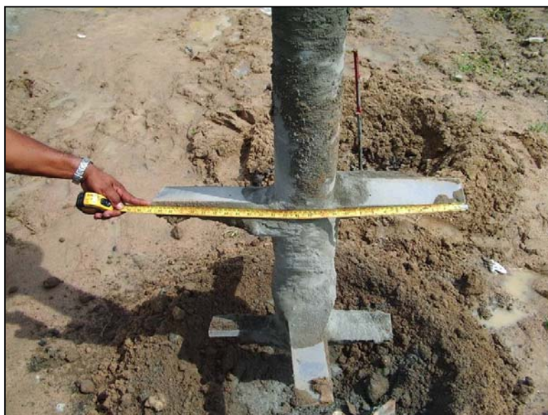
ภาพแสดงลักษณะไบกวนผสมระบบ Dry Mixing และการจัดขนาดของไบการผสม
