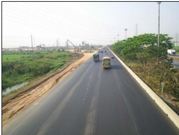
งาน ASPHALT CONCRETE BINDER COURSE
