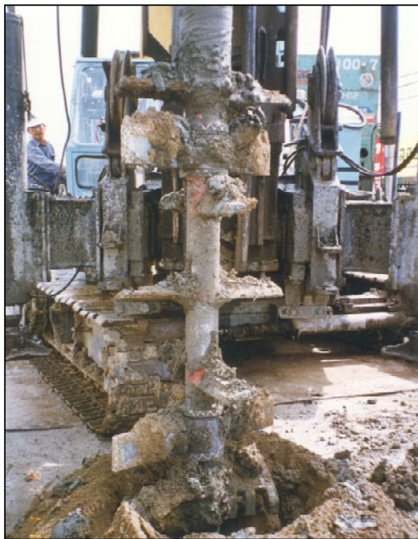
ภาพแสดงลักษณะหัวเจาะของระบบ Wet Mixing
