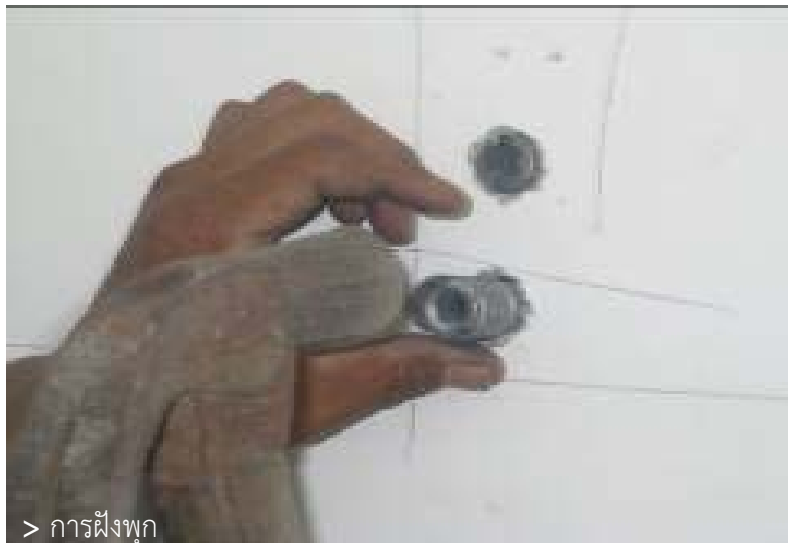
> การเจาะผนังเพื่อยึดขาเหล็ก
