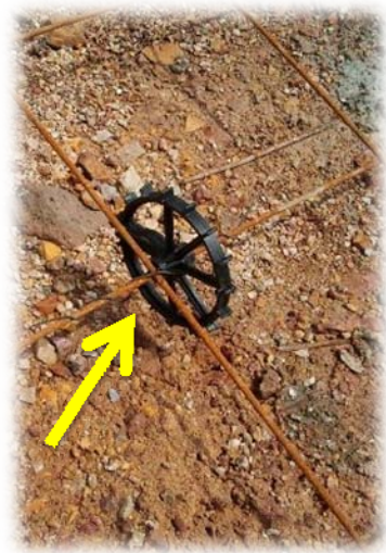
การเสริมเหล็กตะแกรงและเหล็กเสริมพิเศษ
