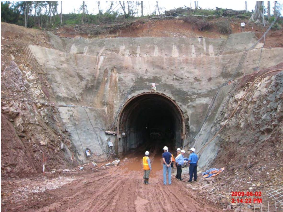
รูปถ่ายที่ 1 : ปากอุโมงค์ผันน้ำทางน้ำออก (Outlet of Diversion Tunnel)
