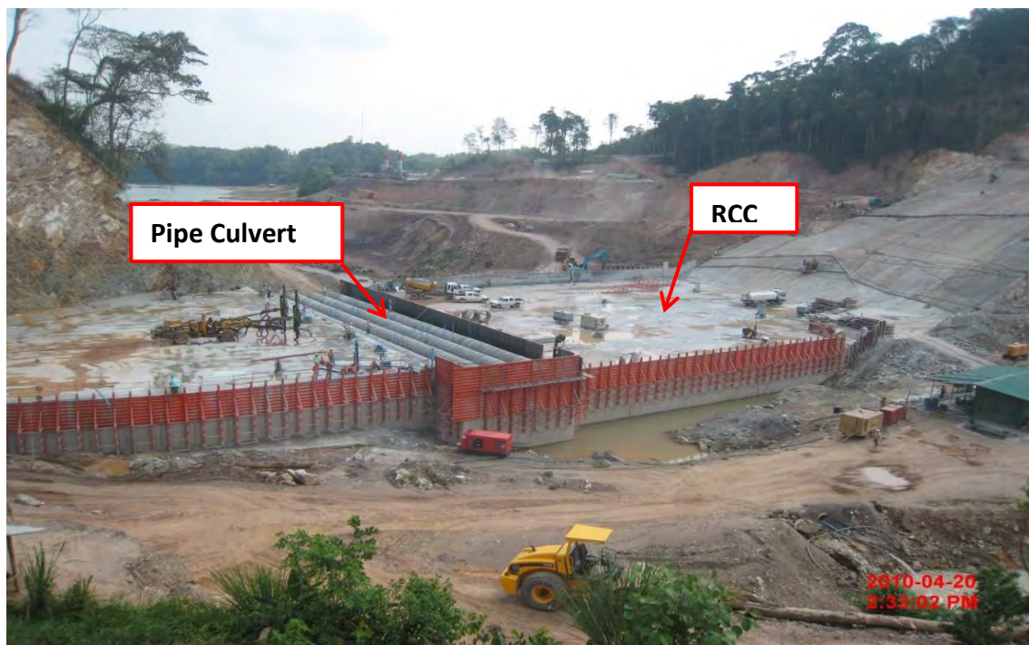
รูปถ่ายที่ 6 : ท่อ Pipe Culvert Ø1.50 m. จำนวน 4 ท่อน เพื่อใช้ระบายน้ำในฤดูแล้ง (2- yr return period ประมาณ 50 \text{ m}^3/\text{s} ) หลังจากเปิด Cofferd Dam. ลดน้ำในอุโมงค์เพื่อเข้าทำงานติดตั้งบานประตู
