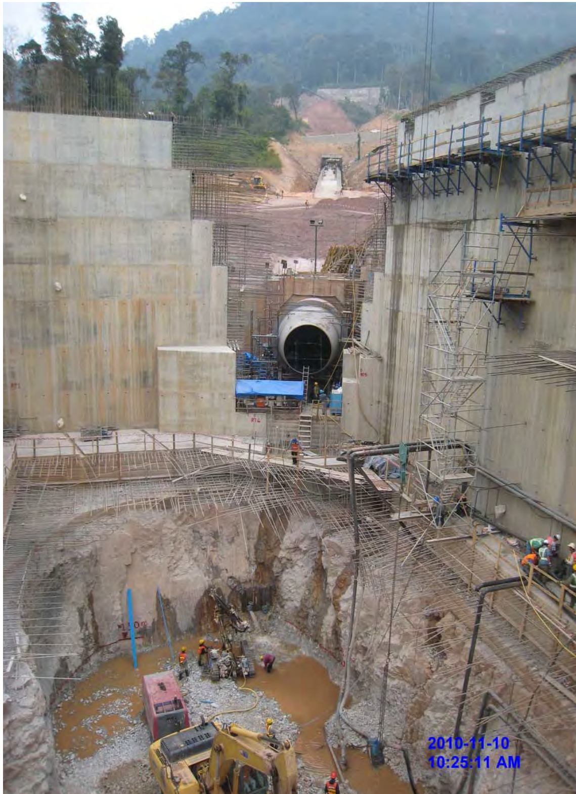
รูปที่ 49 : เมื่อน้ำในบ่อก่อสร้างแห้ง ก็เริ่มทำงานต่อได้ เสียเวลาจัดการกับน้ำรั่วประมาณ 1.5 เดือน
