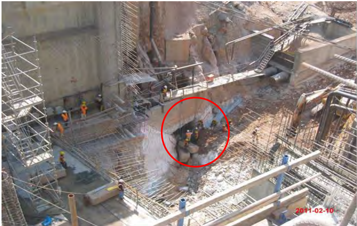
รูปที่ 48 : ขณะเทคอนกรีตปิดบริเวณโพรงที่น้ำเคยรั่วซึมเข้ามา
