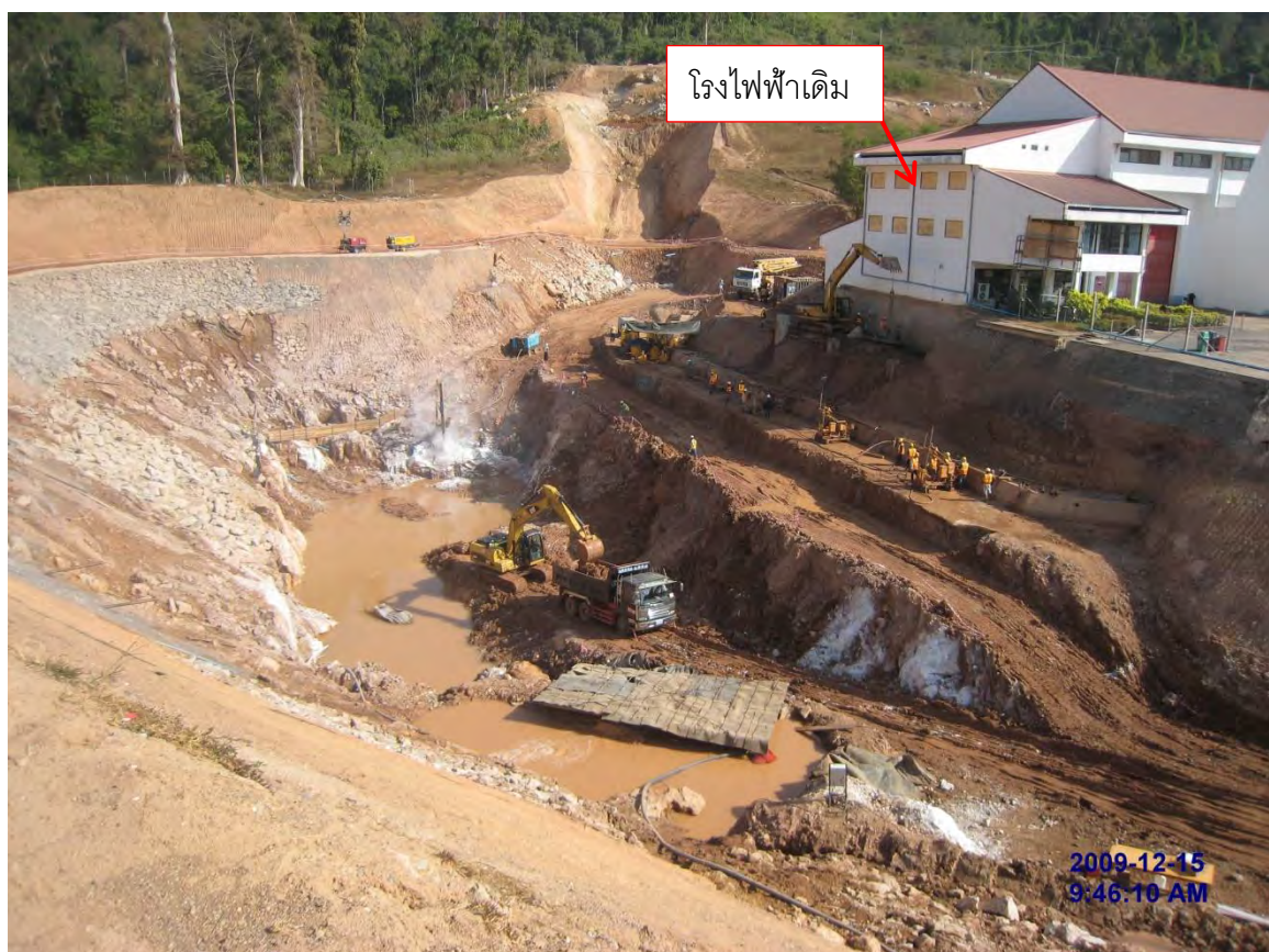
รูปถ่ายที่ 34 : งานขุดฐานรากโรงไฟฟ้าใหม่มีลักษณะเป็นหินปูนมีโพรง (Krust limestone)
