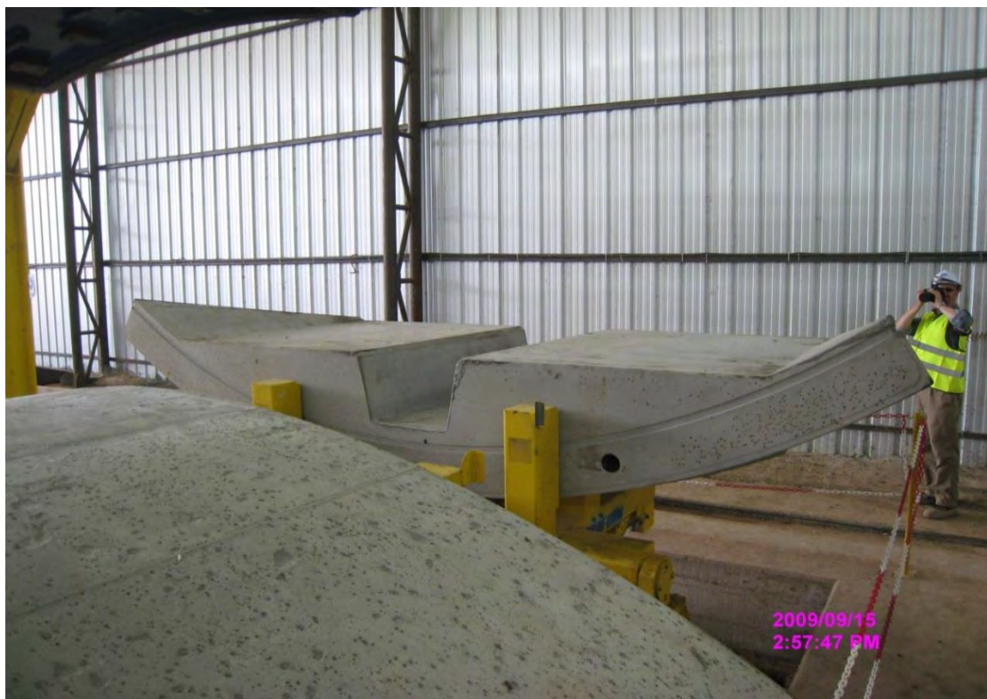
รูปถ่ายที่ 29 : Precast Concrete Segment ในโรงงานหล่อ
