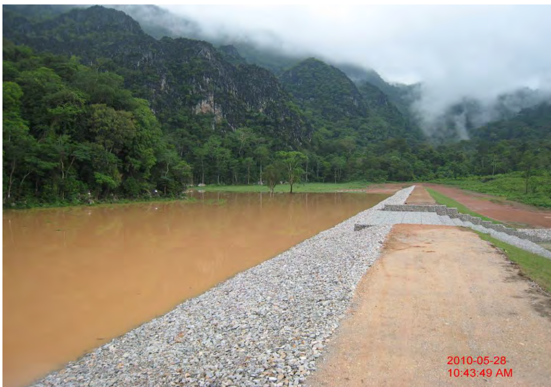
รูปที่ 33 : เขื่อนกั้นน้ำรั่วซึมระยะแรก ระดับสัน 425.00 ม.รทก.
