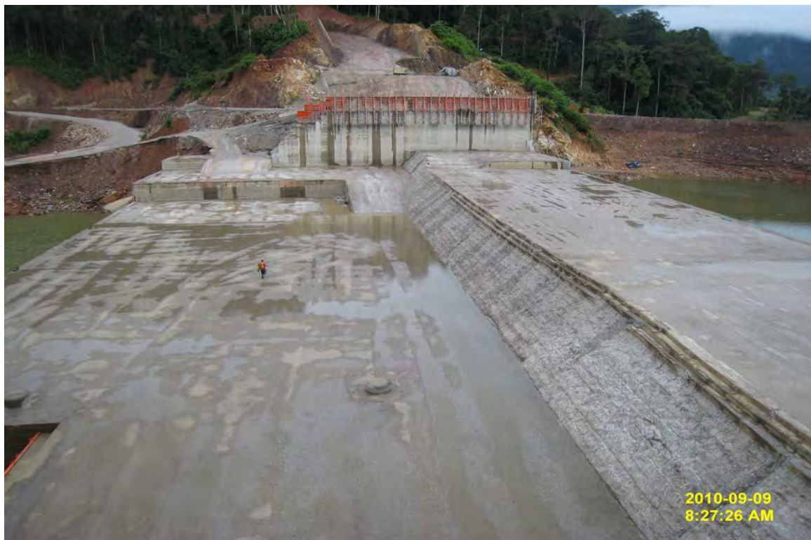
รูปถ่ายที่ 11 : เมื่อน้ำลดแล้วทำความสะอาดแล้วเตรียมเท RCC ต่อ
