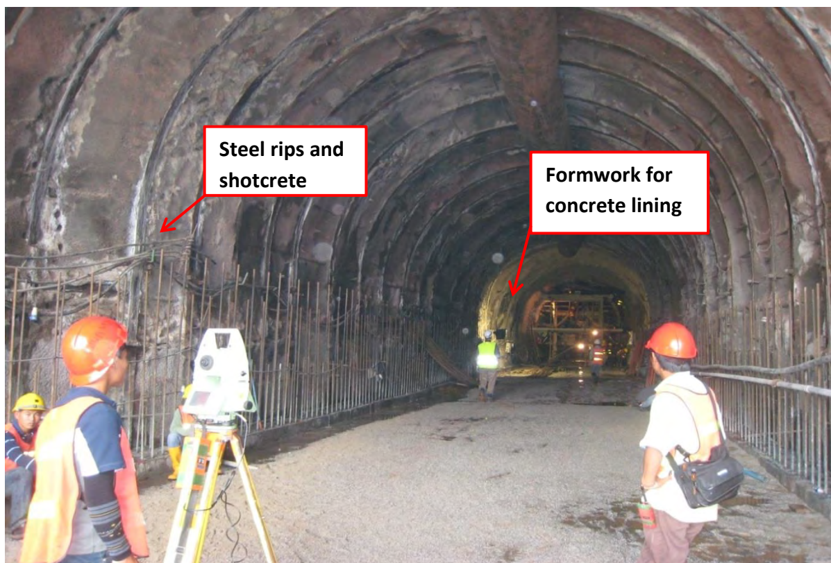
รูปถ่ายที่ 2 : ขณะทำการคาดคอนกรีตผิวอุโมงค์ผันน้ำ (Tunnel Lining)
