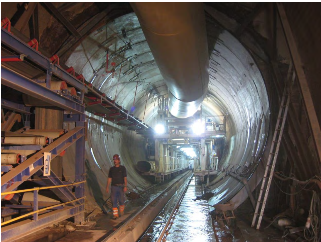
รูปที่ 41 : ขณะเจาะและติดตั้ง PC. Segment ความก้าวหน้าเฉลี่ย 19 ม/วัน ทำได้สูงสุด 34 ม/วัน ใช้เวลาเจาะประมาณ 275 วัน (5,220 ม)
