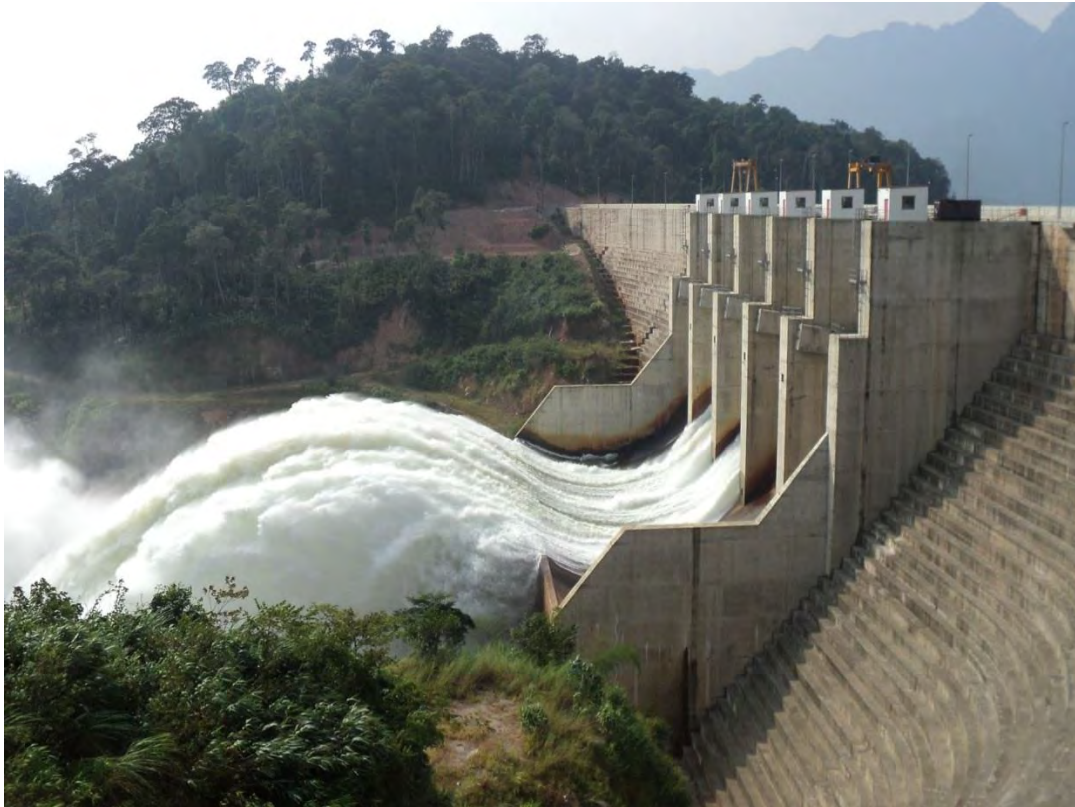
รูปที่ 23 : ขณะทดสอบการเปิดประตูทางน้ำรัน 2 บาน ที่ความสูง 1 ม.
