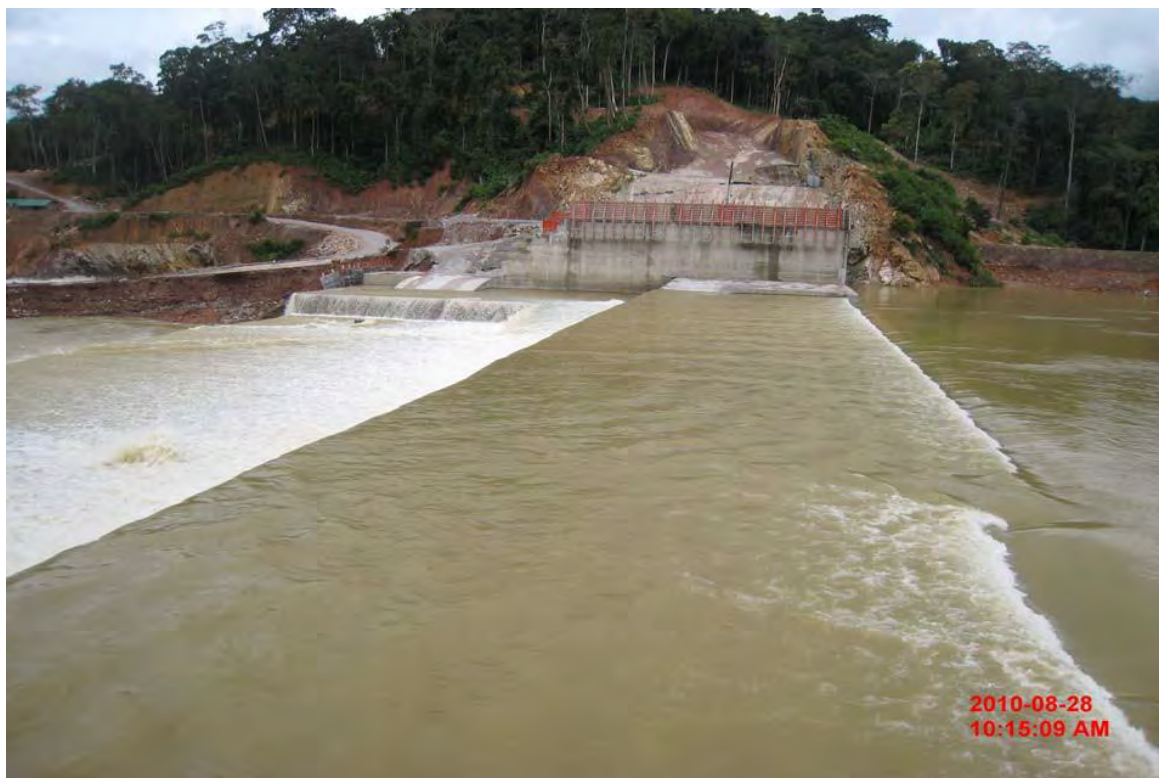
รูปถ่ายที่ 10 : น้ำไหลข้าม RCC ส่วนหน้า แต่ไม่เป็นอันตรายต่อ RCC แต่อย่างใด เมื่อน้ำลดก็ทำงานต่อไปได้
