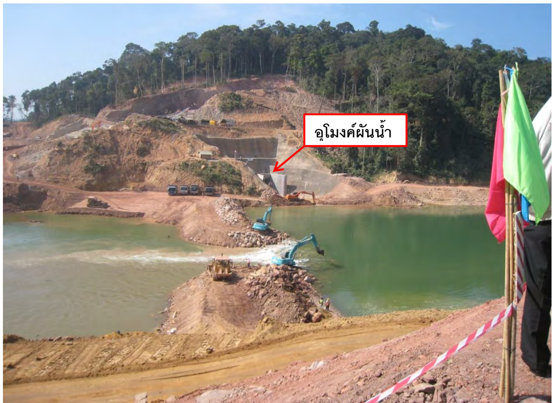
รูปที่ 31 : ขณะทำการผันน้ำเข้าอุโมงค์โดยถมปิดเขื่อนกั้นน้ำชั่วคราว (Cofferdam) เมื่อวันที่ 7 ธ.ค 2551
