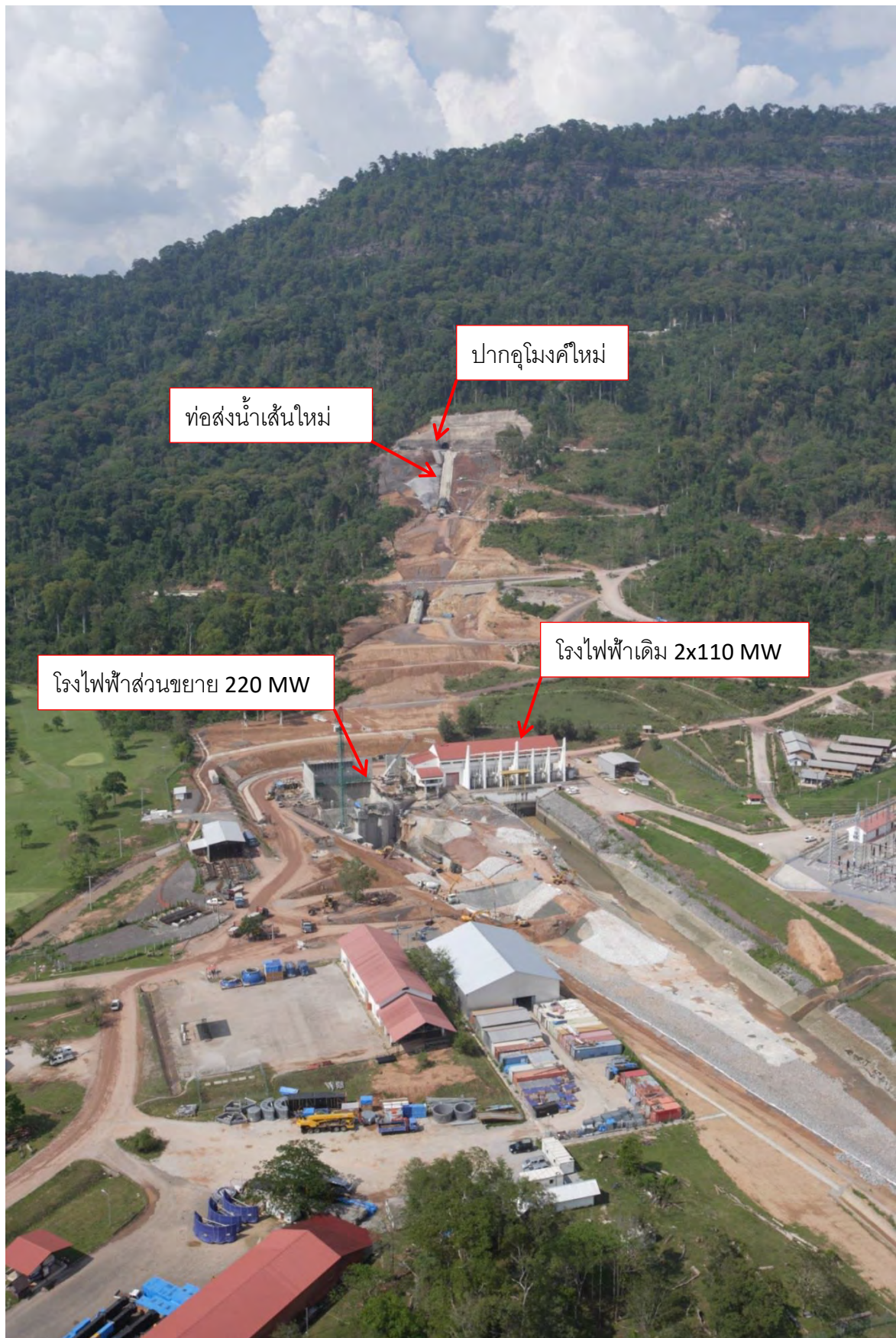
รูปที่ 35 : ภาพถ่ายทางอากาศของท่อส่งน้ำจากอุโมงค์ถึงโรงไฟฟ้าส่วนขยาย
