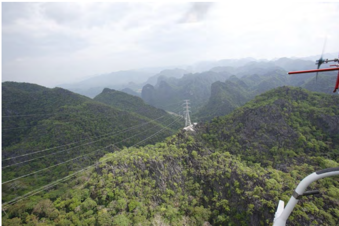
รูปถ่ายที่ 44 : งานติดตั้งเสาสายส่ง 230 kV ไปจังหวัดนครพนม ระยะทางประมาณ 86 ก.ม. ในภาพเป็นช่วงที่ข้ามภูเขาหินปูน (Limestone Ridge) ต้องใช้ Helicopter ในการขนส่งวัสดุทั้งหมด
