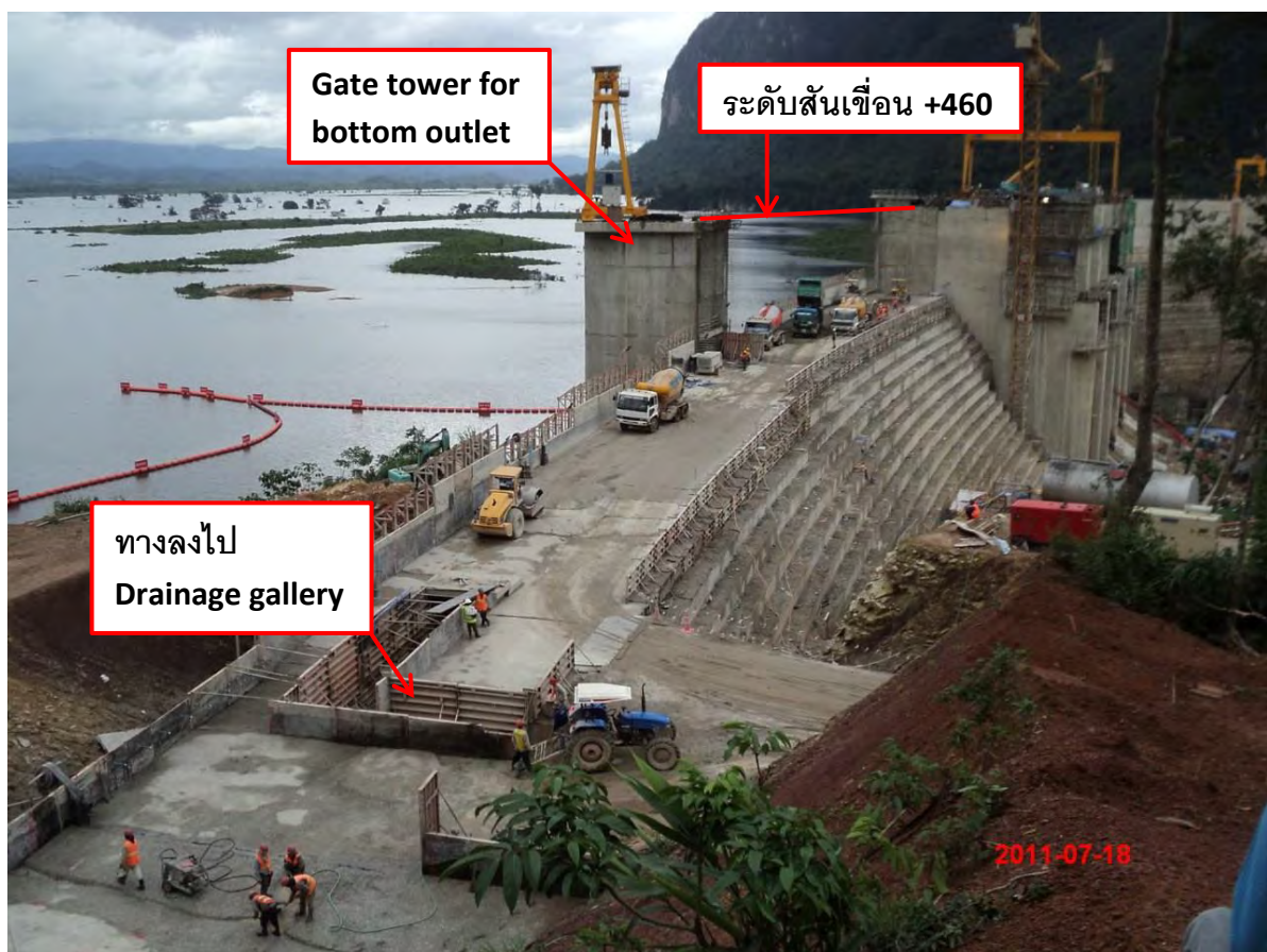
รูปถ่ายที่ 14 : เมื่อเท RCC เเท้ได้ระดับที่เหมาะสมก็เริ่มเก็บกักน้ำเข้าอ่าง
