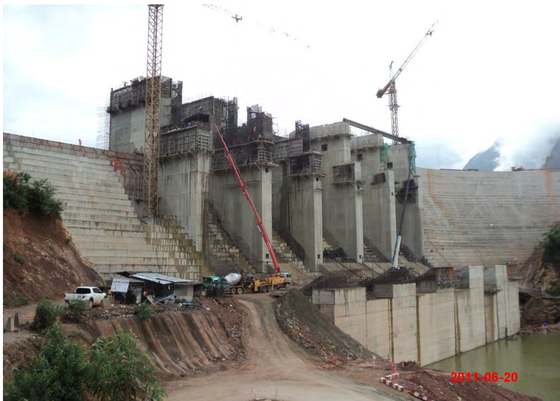
รูปถ่ายที่ 16 : งานก่อสร้าง Spillway จำนวน 5 ช่องบริเวณช่วงกลางของเขื่อน
