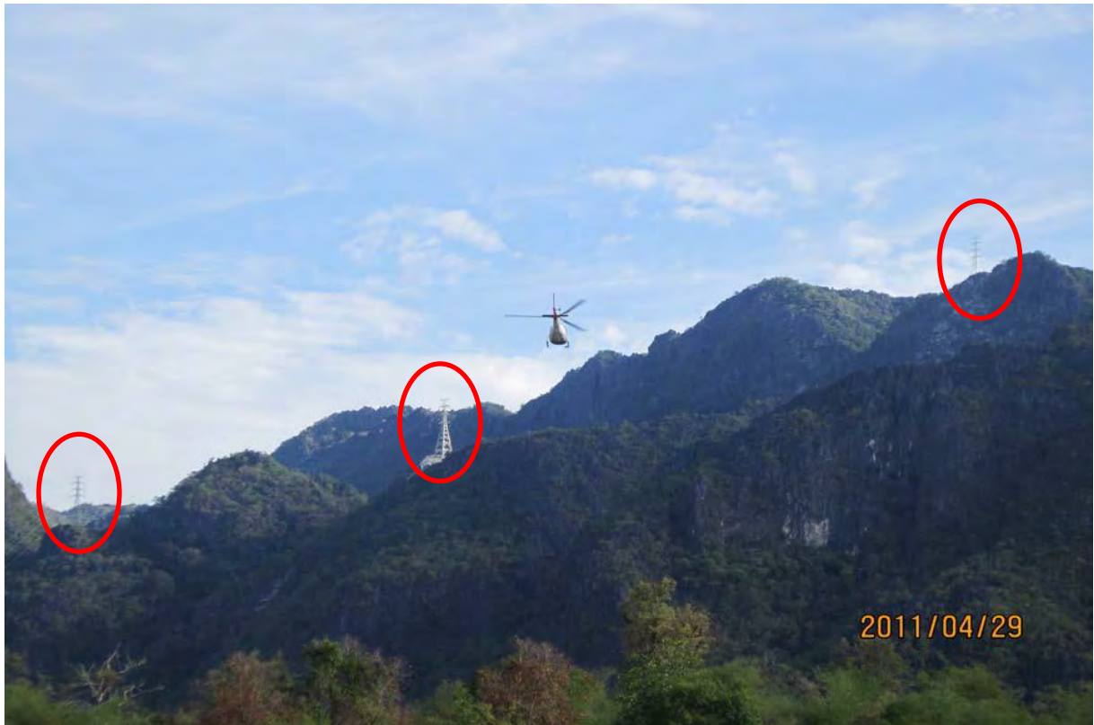
รูปถ่ายที่ 45 : งานขึงสายไฟฟ้าแรงสูงโดย Helicopter บนภูเขาหินปูน
