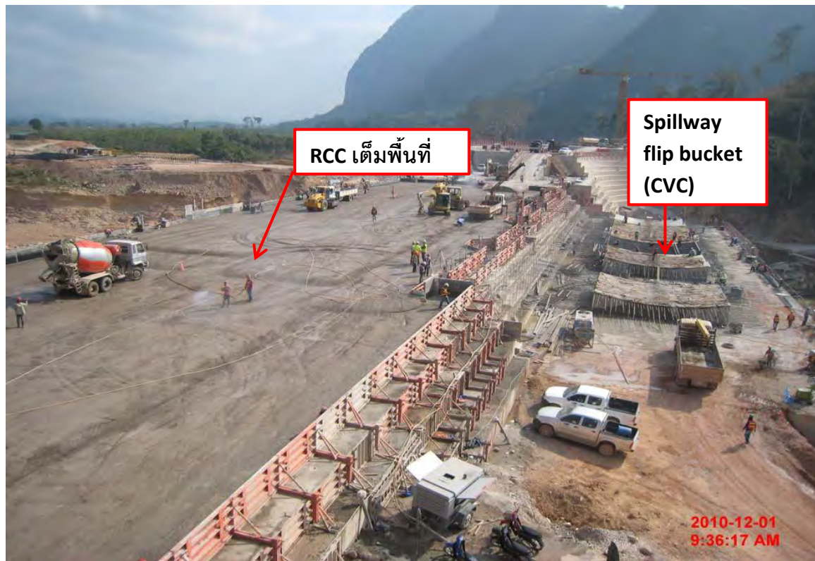
รูปถ่ายที่ 13 : ขณะเท RCC เดิมพื้นที่และ Spillway flip bucket (Conventional Vibrated Concrete, CVC)
