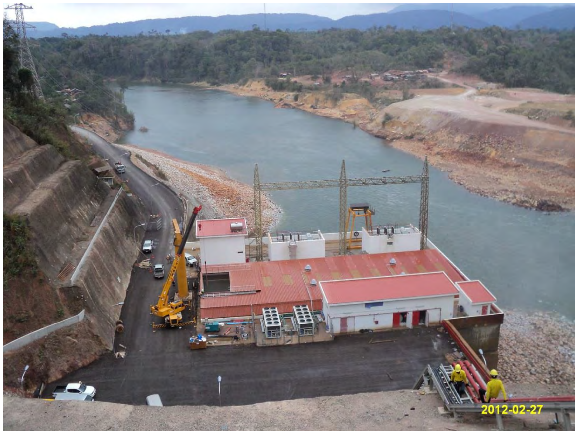
รูปถ่ายที่ 23 : อาคารโรงไฟฟ้าเขื่อนน้ำยวงแล้วเสร็จสมบูรณ์
