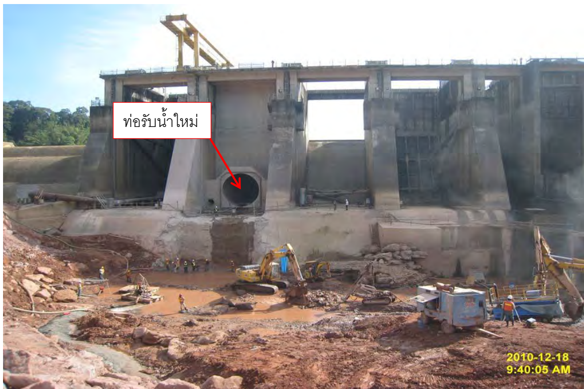
รูปถ่ายที่ 25 : งานแก้ไขปรับปรุงฝายเดิมเพื่อเพิ่มท่อบรับน้ำเข้าอุโมงค์ใหม่ (Weir modification for new intake)
