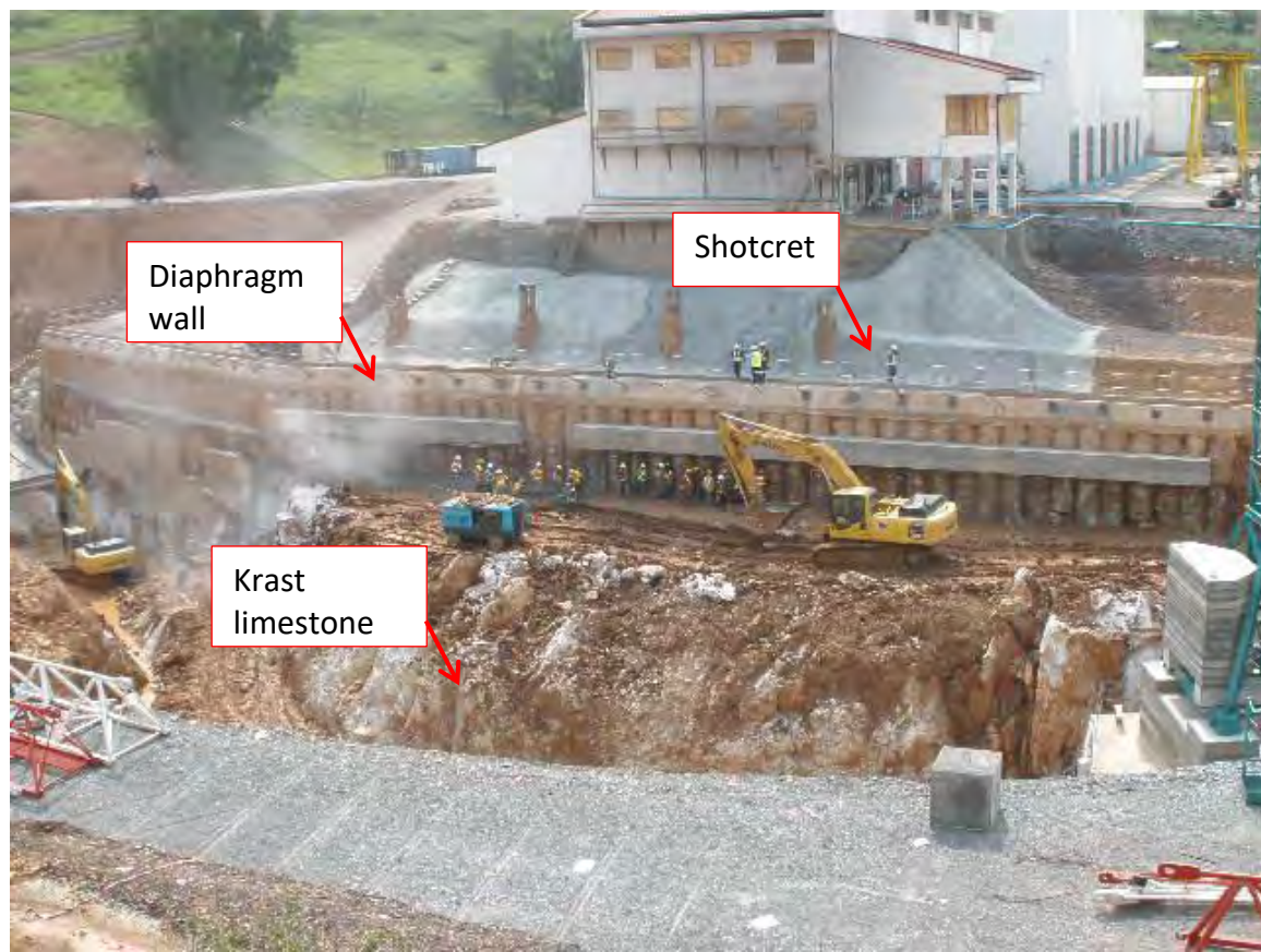
รูปถ่ายที่ 35 : เนื่องจากโรงไฟฟ้าใหม่อยู่ติดกับโรงไฟฟ้าเดิม ดังนั้นงานขุดฐานรากต้องป้องกันการเคลื่อนตัวของดิน โดยติดตั้ง Diaphragm Wall ตลอดแนวที่อยู่ติดกัน
