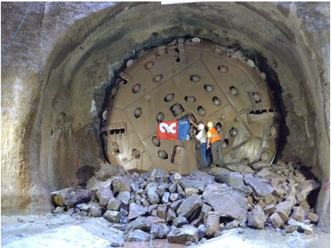
รูปถ่ายที่ 31 : เจาะทะลุสมบูรณ์แบบ เตรียมยกหัวเจาะ TBM ออกจาก Dismantle Shaft
