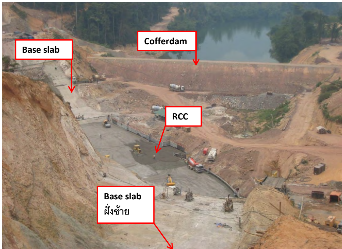
รูปถ่ายที่ 5 : คอนกรีตบดอัด (RCC) บริเวณส่วนกลางและ Base concrete slab ส่วนบนฝั่งซ้ายและขวา
