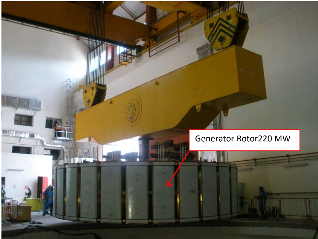
รูปถ่ายที่ 41 : เครื่องกำเนิดไฟฟ้าส่วนหมุน Rotor
