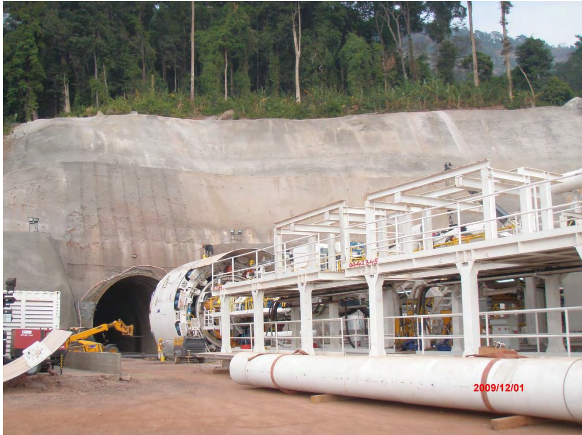
รูปถ่ายที่ 28 : หัวเจาะ และ Backup system เตรียมเคลื่อนเข้าอุโมงค์
