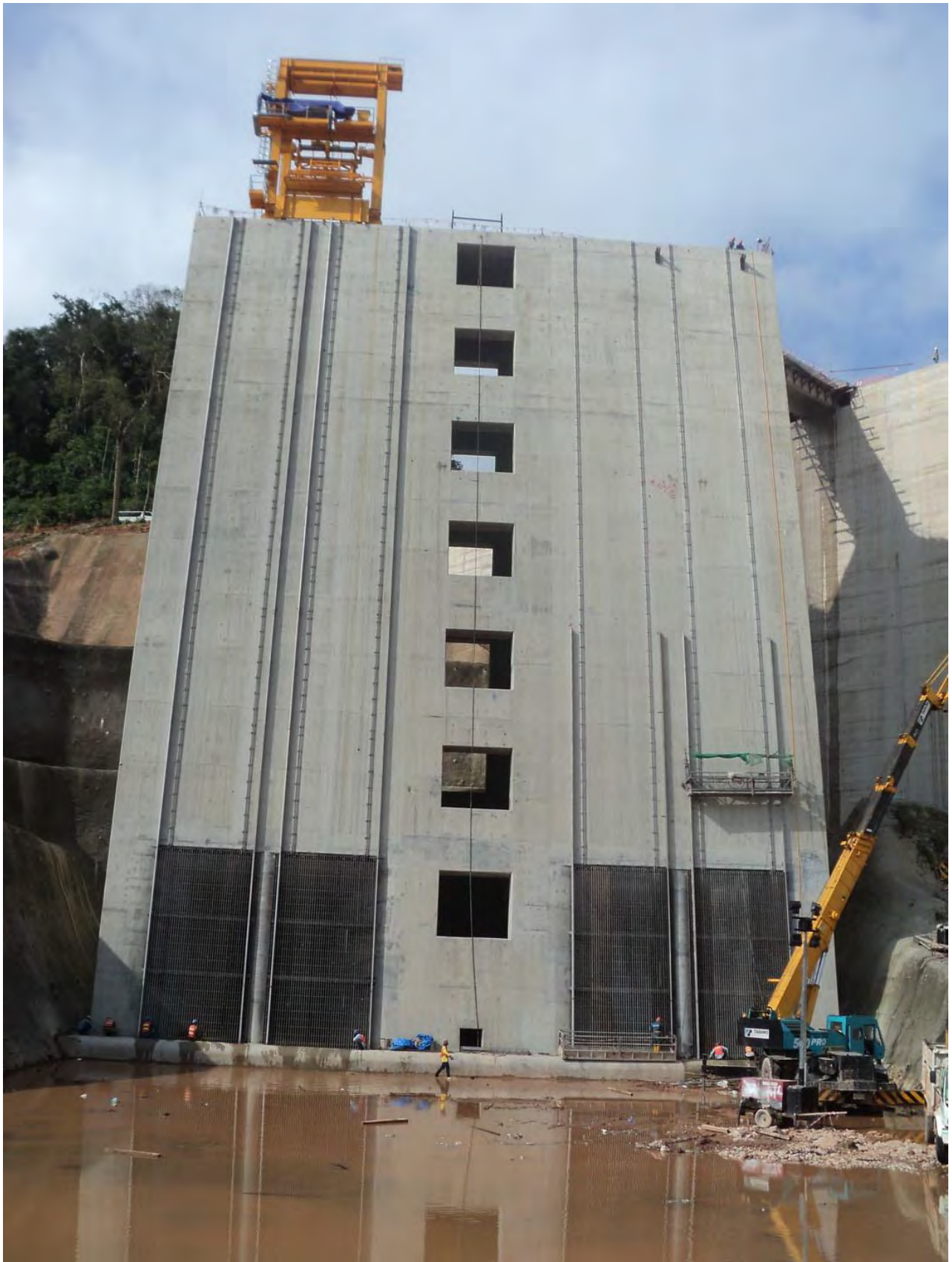
รูปถ่ายที่ 19 : ขณะติดตั้งตะแกรงกันขยะและเครื่องดักขยะหน้าอาคารรับน้ำ (Intake Tower)
