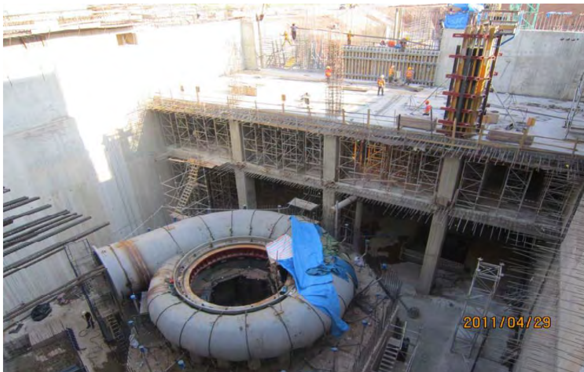
รูปถ่ายที่ 39 : งานติดตั้ง Spiral Case รับน้ำมาหมุนเครื่อง Turbine
