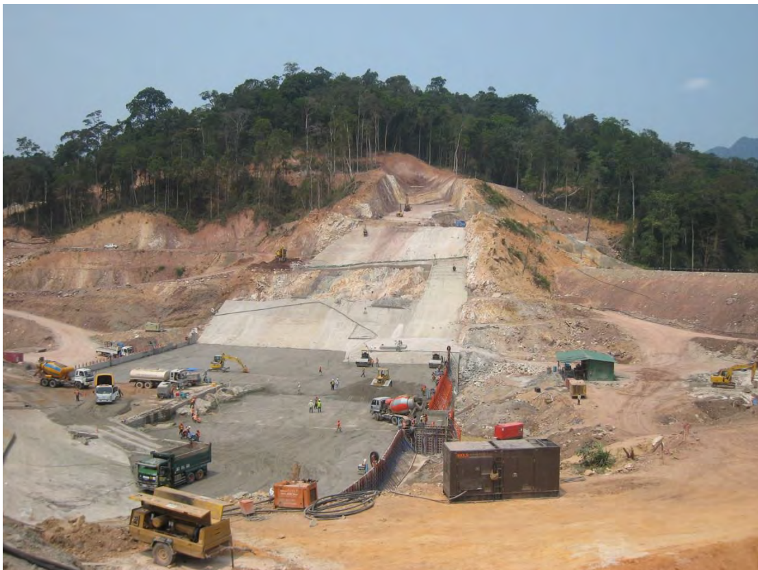
รูปที่ 16 : ขณะเทคอนกรีตบดอัดบริเวณช่วงกลาง
