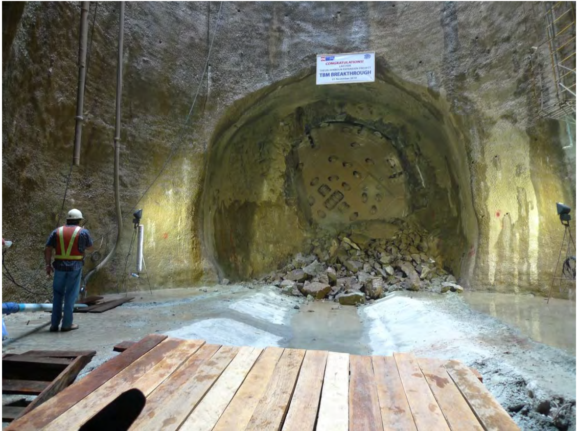
รูปถ่ายที่ 30 : TBM เจาะทะลุถึง Dismantle Shaft (Breakthrough) เมื่อ 21 พ.ย 2553
