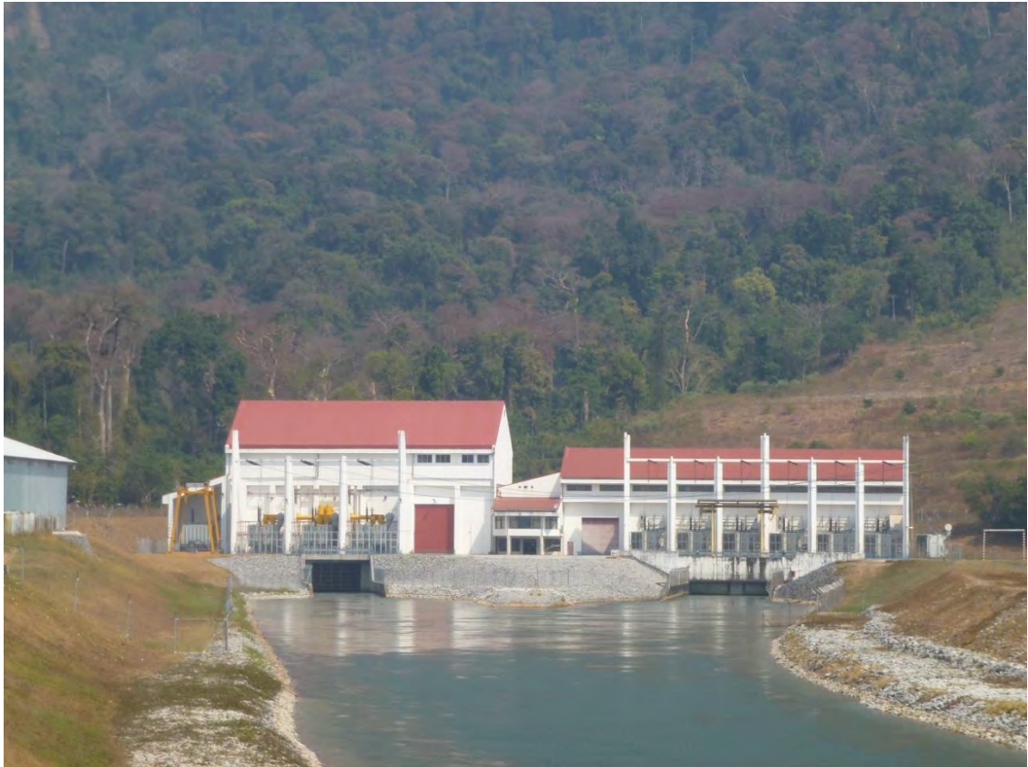
รูปถ่ายที่ 43 : โรงไฟฟ้าส่วนขยายแล้วเสร็จสมบูรณ์
