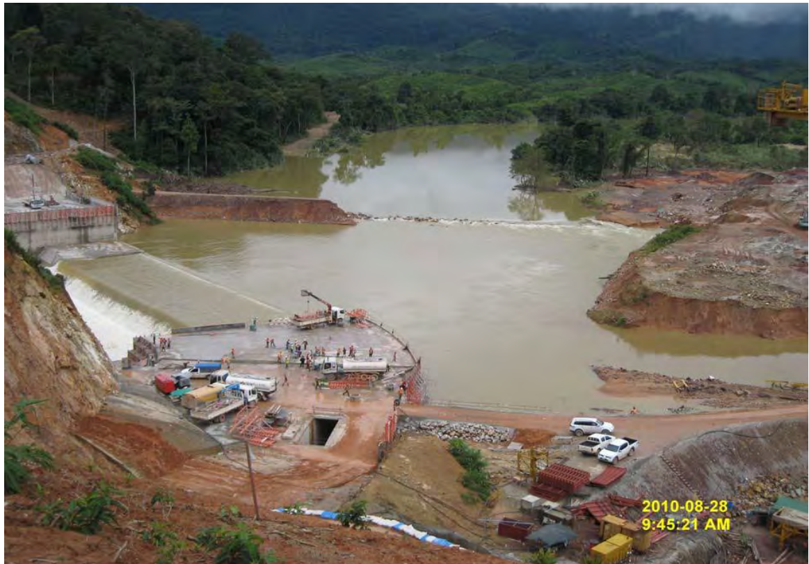
รูปถ่ายที่ 9 : เกิดเหตุการณ์น้ำใต้ไหลหลากข้าม Cofferdam และ RCC ส่วนหน้า เมื่อ 28 สิงหาคม 2553 (ได้คาดการณ์ไว้แล้ว)
