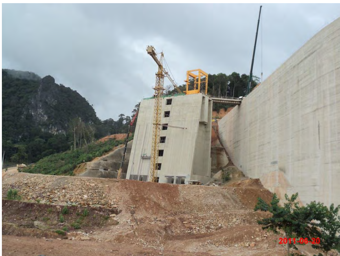
รูปที่ 25 : อาคารรับน้ำ (Intake Tower)
