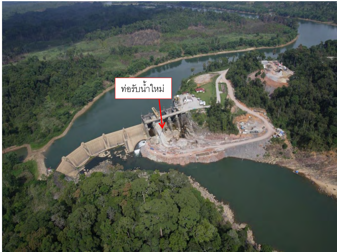
รูปถ่ายที่ 24 : ฝ่ายกั้นแม่น้ำเหินของเดิม (Existing Weir) ก่อสร้างแล้วเสร็จเมื่อพ.ศ. 2540
