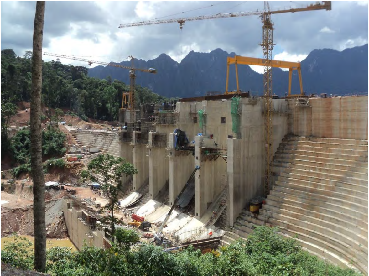
รูปถ่ายที่ 17 : งานก่อสร้าง Spillway มองจากด้านซ้าย
