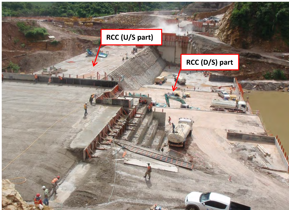
รูปถ่ายที่ 7 : คอนกรีตบดอัด (RCC) ส่วนหน้าและส่วนหลัง โดยทำส่วนหน้าก่อนให้สูงกว่าส่วนหลัง
