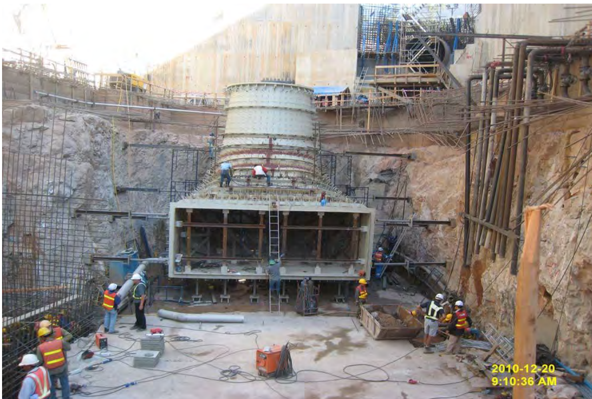
รูปถ่ายที่ 38: งานติดตั้ง Draft Tube เป็นส่วนที่อยู่ใต้เครื่อง Turbine เพื่อระบายน้ำหลังจากที่ปั่น Turbine แล้วออกคลองท้ายน้ำ
