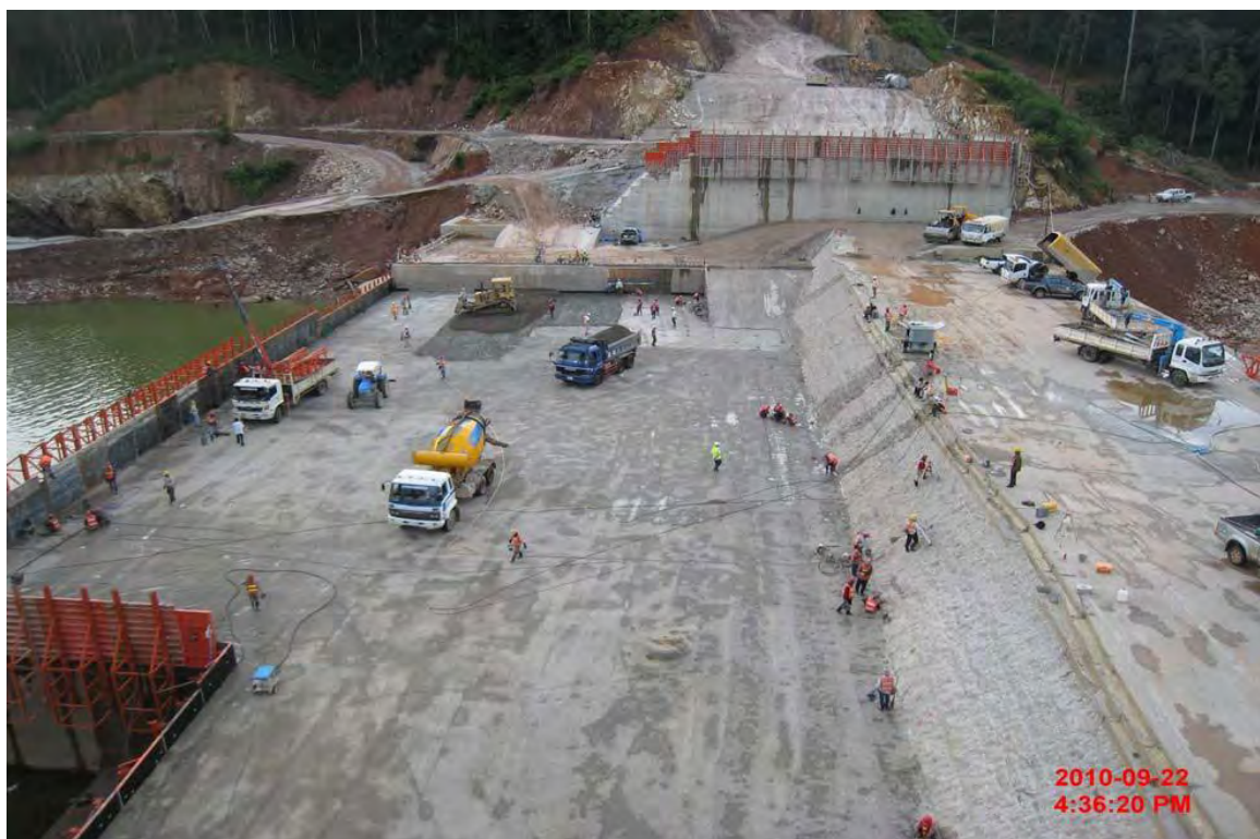
รูปถ่ายที่ 12 : ขณะทำการเท RCC ต่อ
