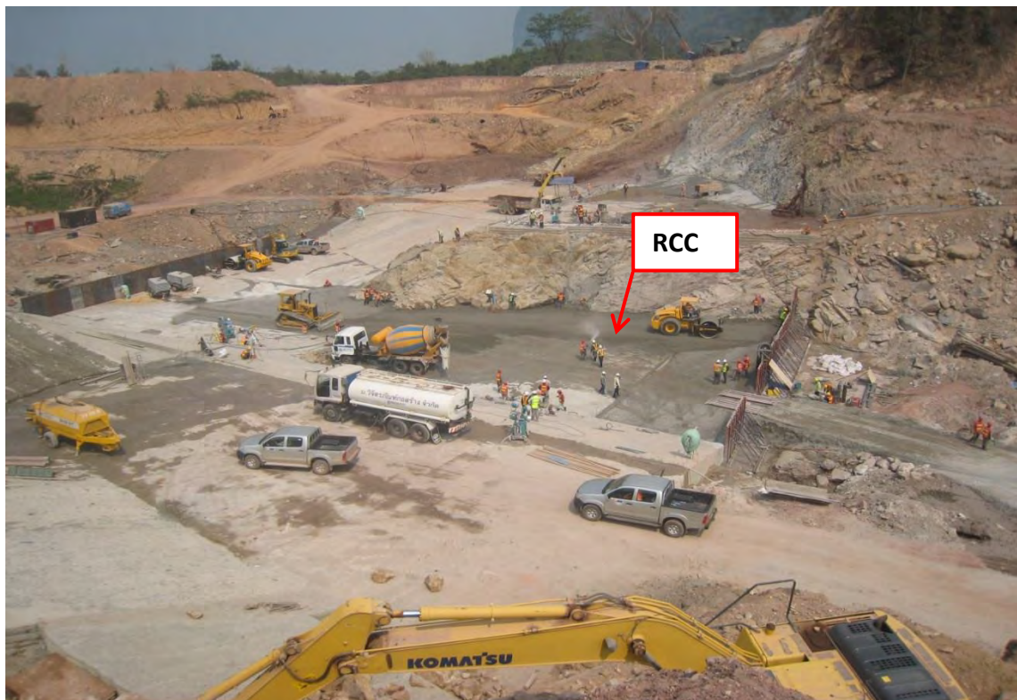
รูปถ่ายที่ 3 : เริ่มงานคอนกรีตบดอัด (RCC) บริเวณฐานรากห้องแม่ น้ำ
