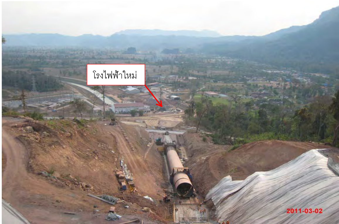
รูปถ่ายที่ 33 : ท่อส่งน้ำ (Penstock) เป็นแบบท่อเหล็ก Ø5.50 ม. หุ้มด้วยคอนกรีตฝังดิน ต่อจากอุโมงค์เข้าโรงไฟฟ้าใหม่ มองจากด้านบน
