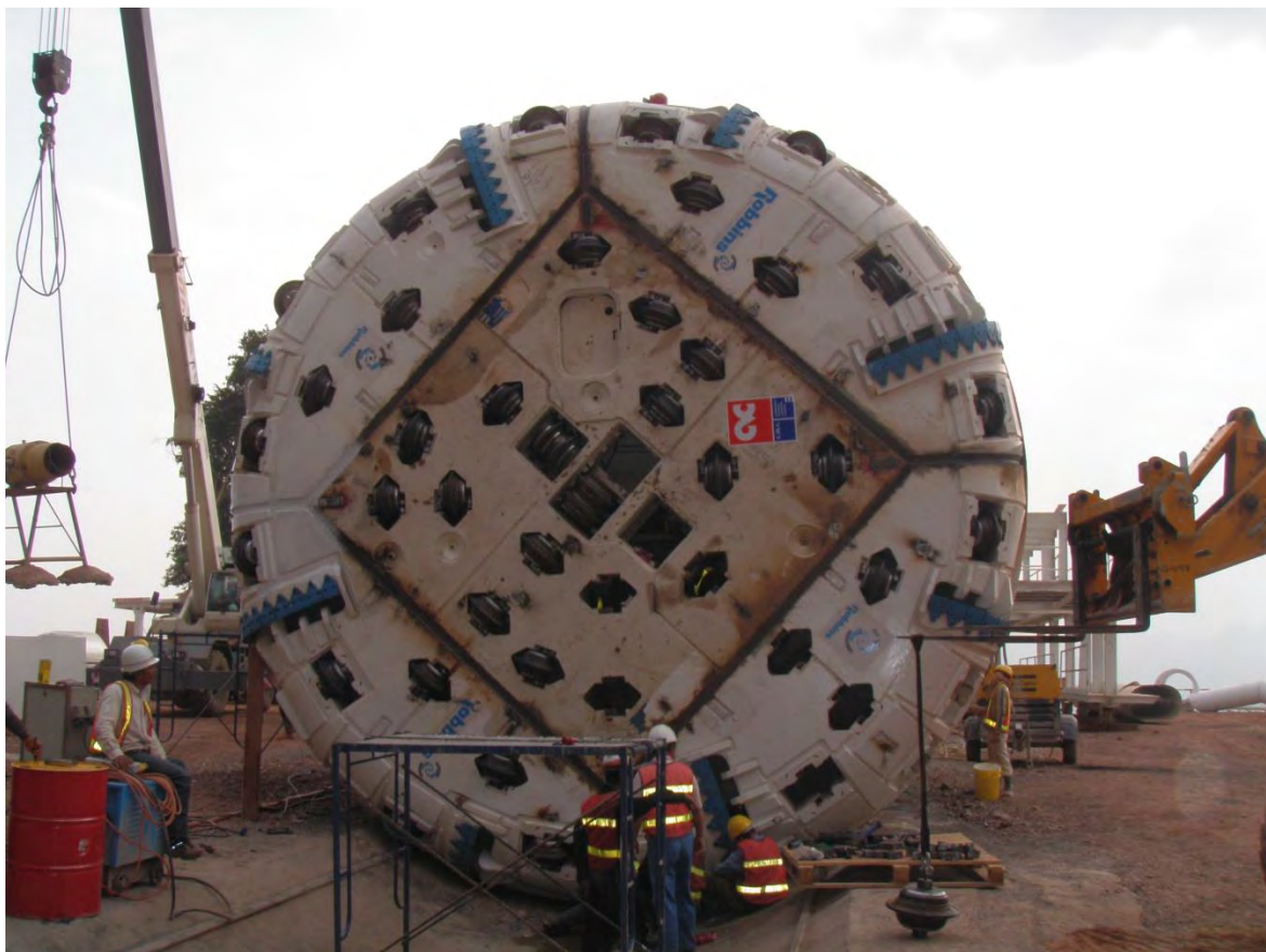
รูปถ่ายที่ 27 : หัวเจาะ แบบ Single Shield Rock Tunnel Boring Machine Ø 7.40 m (Robbins USA)
