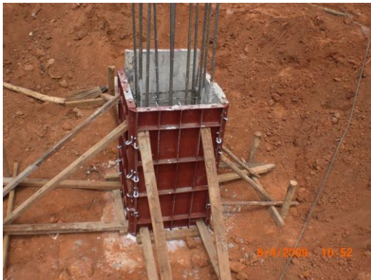
๕) ตรวจสอบดูเครื่อก้ายัน การยึดโยงต้องมั่นคงแข็งแรง
