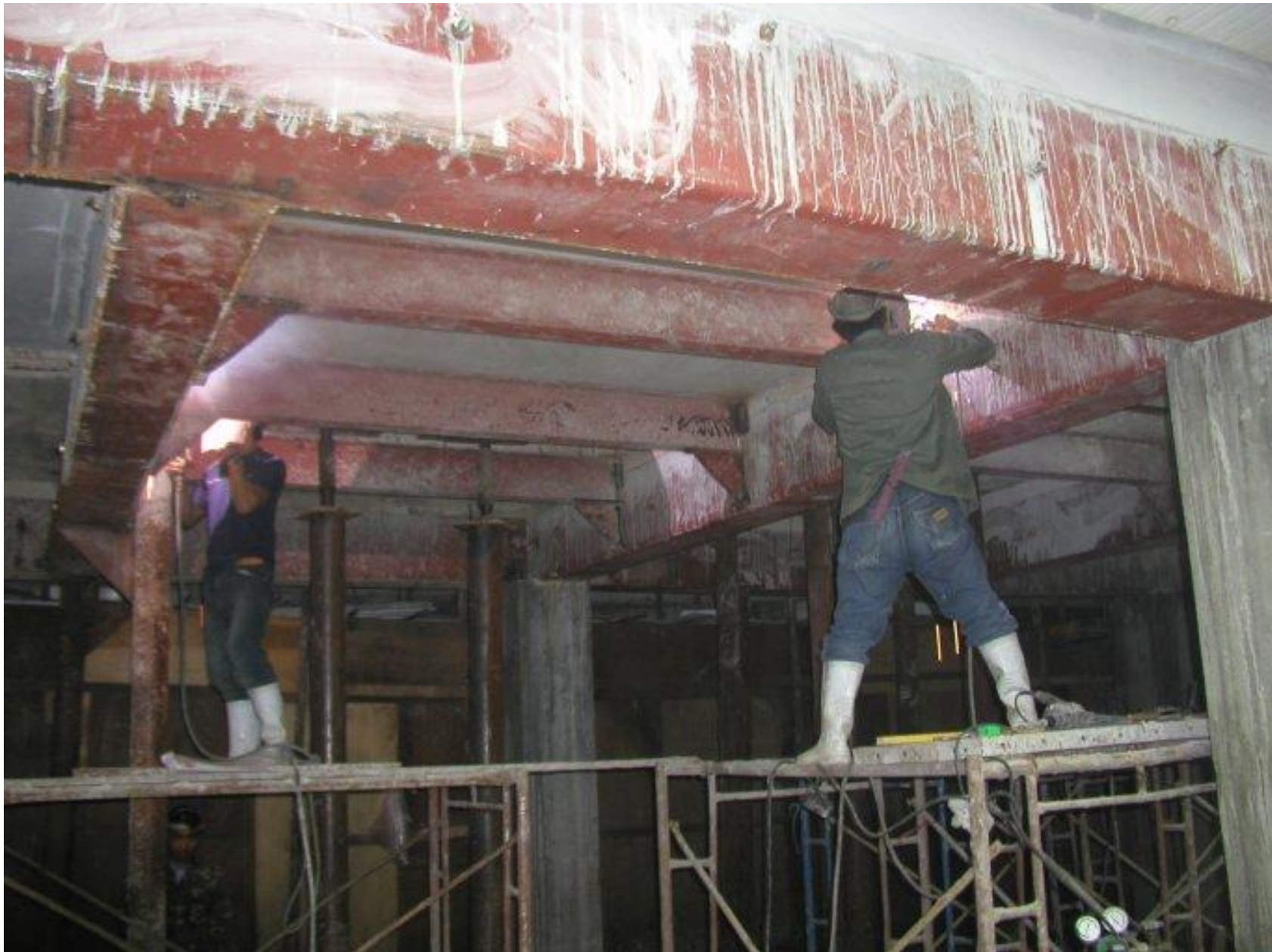
ทำการประกับเหล็กเพื่อเสริมความแข็งแรงคานรับห้องเครื่อง
