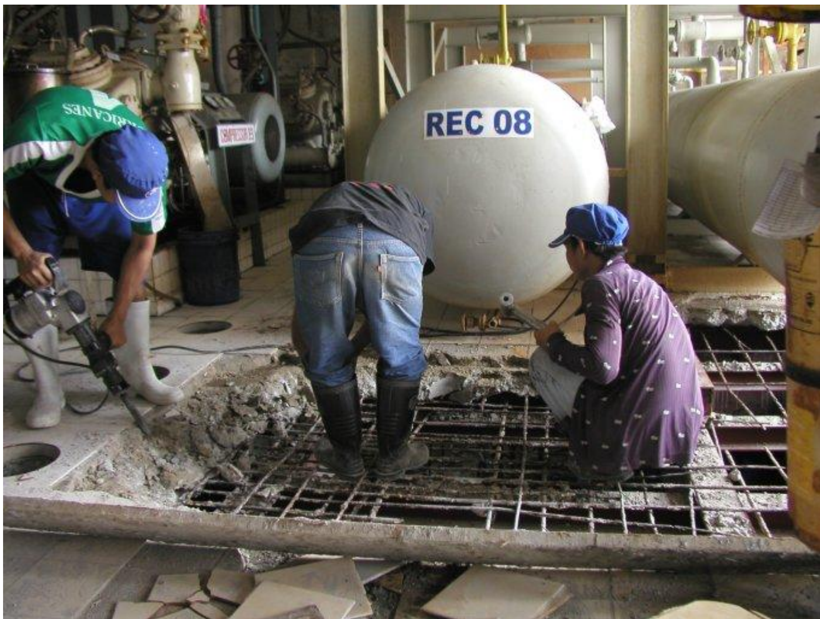
สกัดพื้นส่วนที่เป็นสนิมมากออกทีละส่วน
