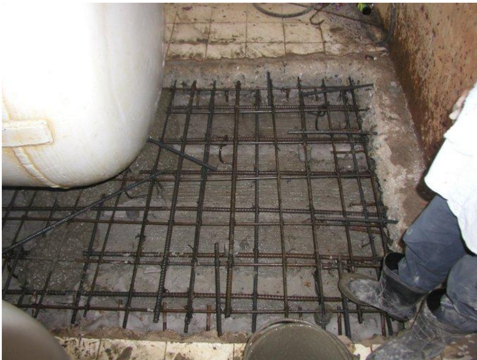
วางแผ่นพื้นสำเร็จรูปและเสริมเหล็กเพิ่ม
