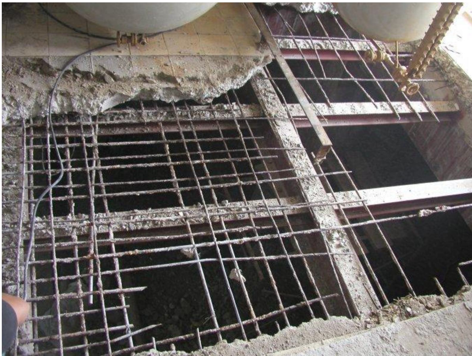
สกัดพื้นที่เสียหายมากทิ้ง ภายหลังเสริมคานเหล็กเสร็จแล้ว
