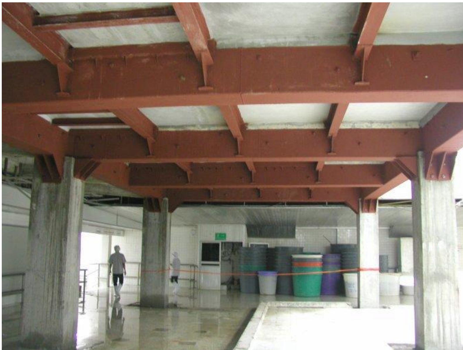
สภาพโครงสร้างภายหลังจากเสริมความแข็งแรงเสร็จสิ้น
