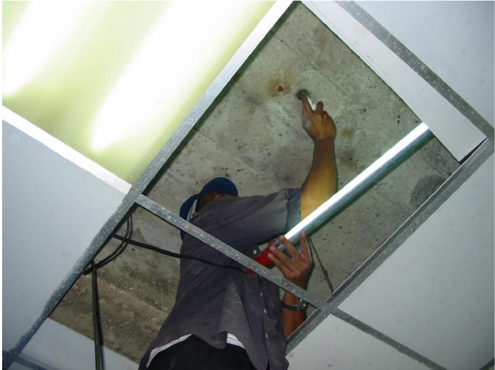
ทำการทดสอบความลึกของปฏิกิริยา Carbonation
