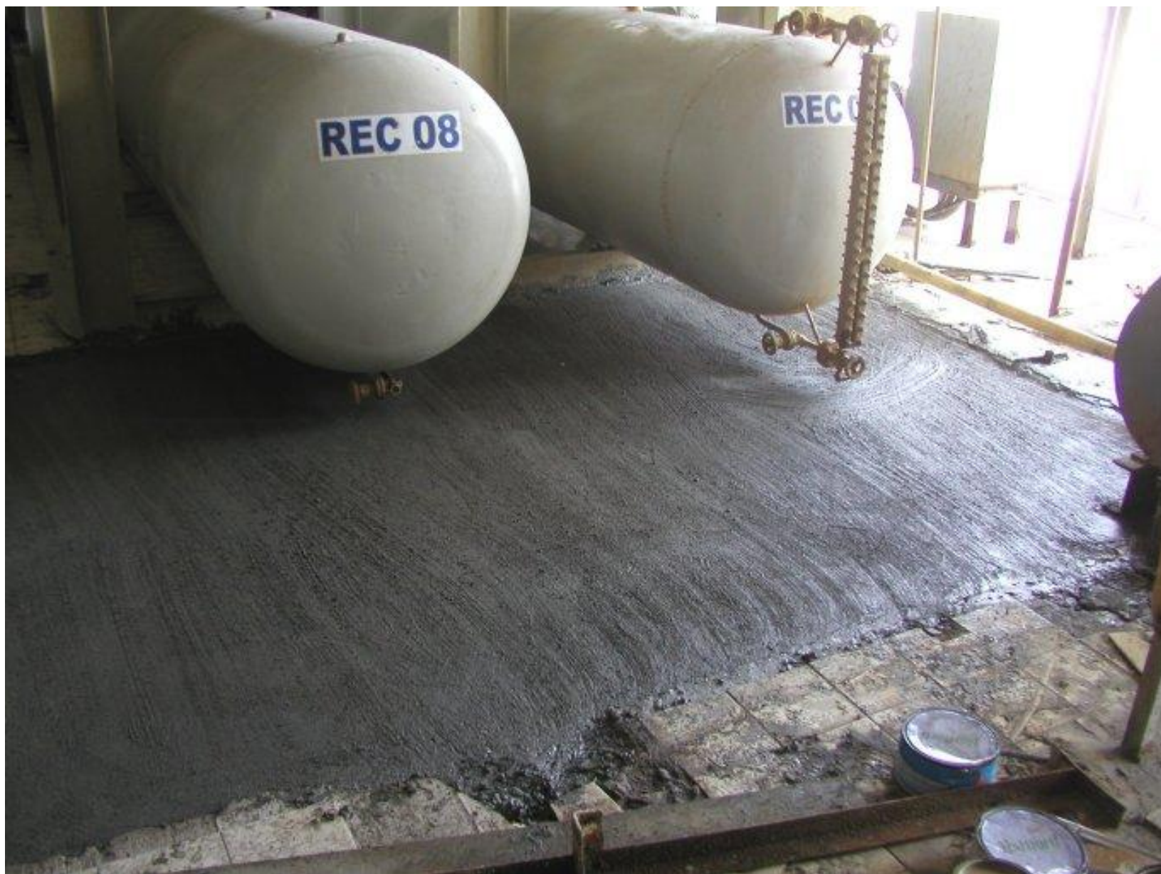
เทพื้นห้องเครื่องด้วยคอนกรีตชนิดพิเศษผสม Fly Ash
