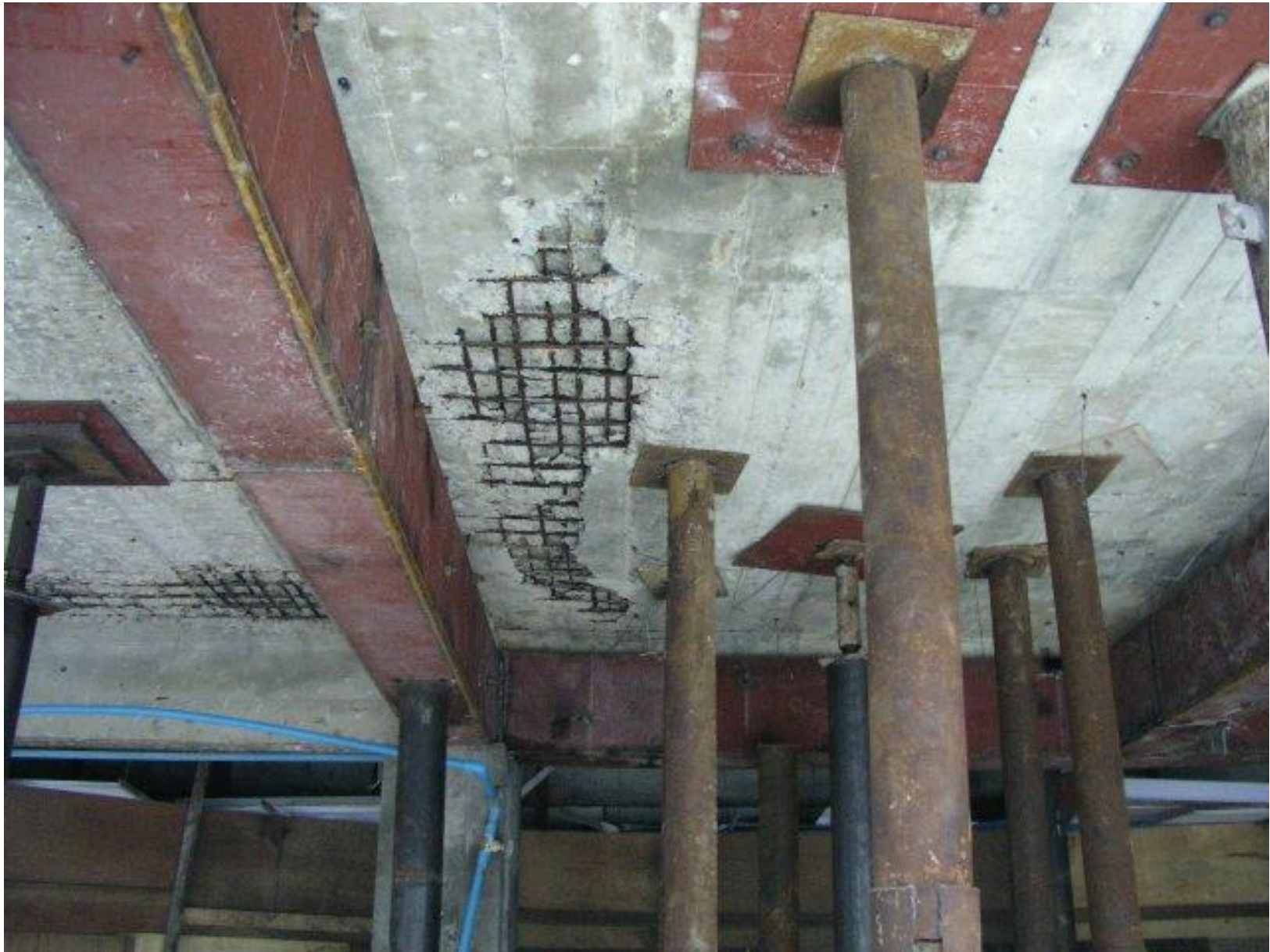
ดำเนินการติดตั้งค้ำยันอาคารเพื่อป้องกันอันตราย
