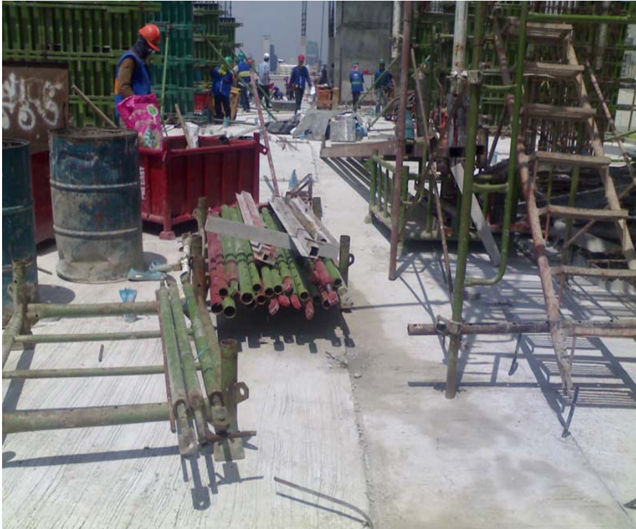
จัดแบ่ง Zoneที่จะกองของอุปกรณ์ไม้แบบ ให้เป็นกลุ่มเป็นZoneเพื่อไม่ให้ขวางแนวตีเส้น และต้องย้ายแบบ สิ่งของ ซ้ำอีกครั้ง
