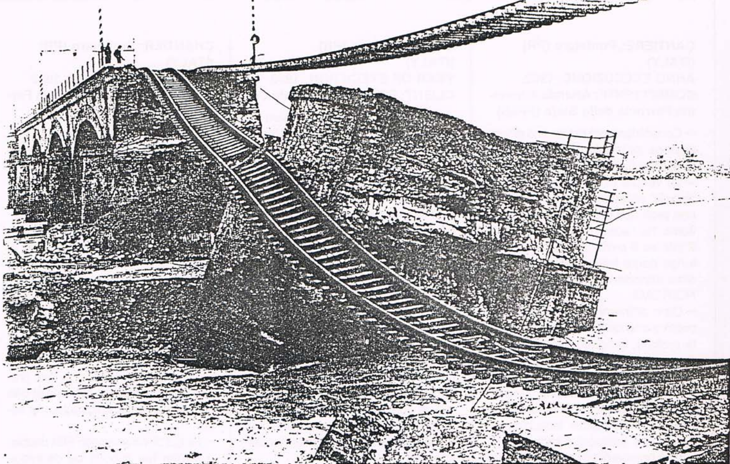
Pile crollate - Collapsed piers - Piles tombées
