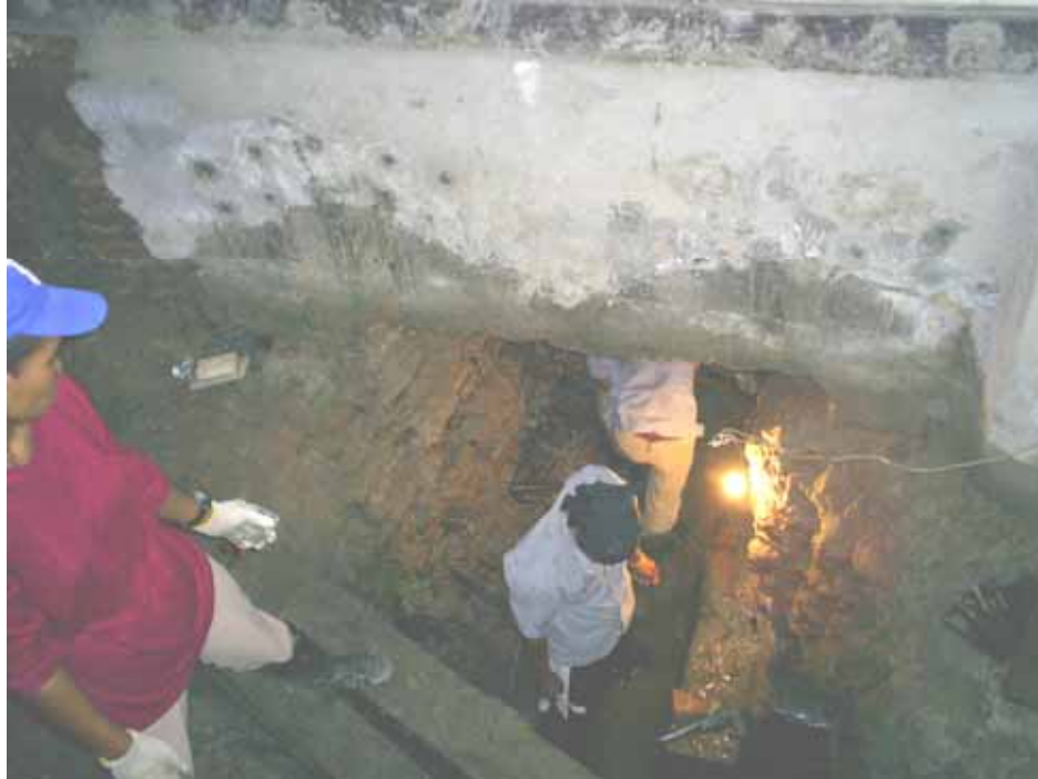
ขุดดินใต้ผนังอิฐก่อให้ได้ความลึกเพียงพอเพื่อติดตั้งเสาเข็ม ความลึกที่ขุดประมาณ 2.50 ม.
