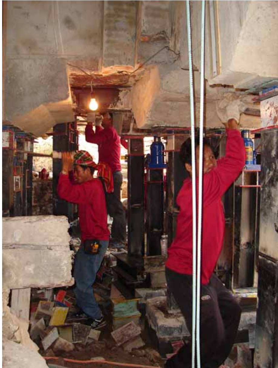
ภาพแสดงการโยกแม่แรงขณะยกอาคารขึ้น
