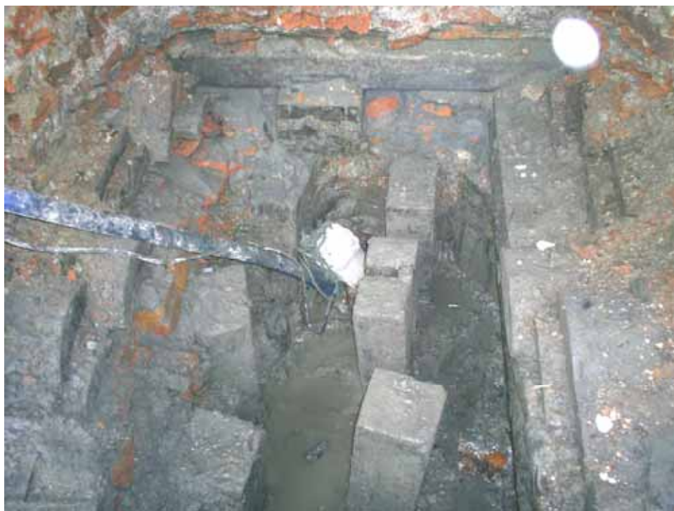
ขอนไม้แต่ละท่อนจะรองรับด้วยเสาเข็มหน้าตัดสี่เหลี่ยมขนาด 0.20 x 0.20 ม. จำนวน 4 ต้น
