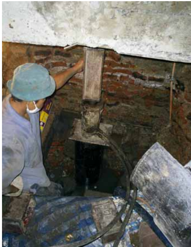
ติดตั้งเสาเข็มโดยใช้แม่แรงไฮดรอลิกกดเสาเข็มลงดิน เสาเข็มที่ใช้เป็นเสาเข็มเหล็กกลมขนาดเส้นผ่านศูนย์กลาง 0.20 ม. และ 0.25 ม. ความลึก 18 20 ม.
