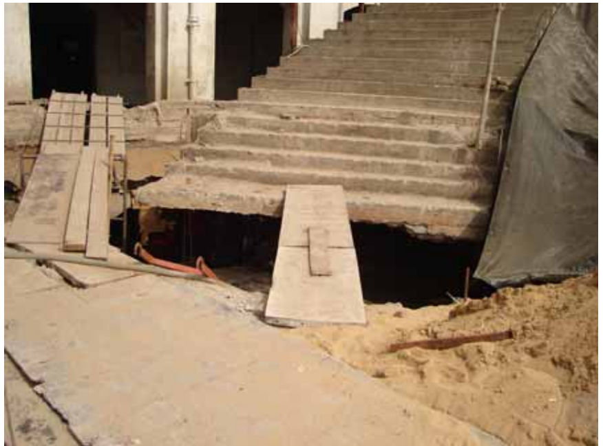
บันไดคอนกรีตเสริมเหล็กส่วนที่เป็น โครงสร้างใหม่ก็ถูกยกลอยสูงขึ้นมา ด้วย
