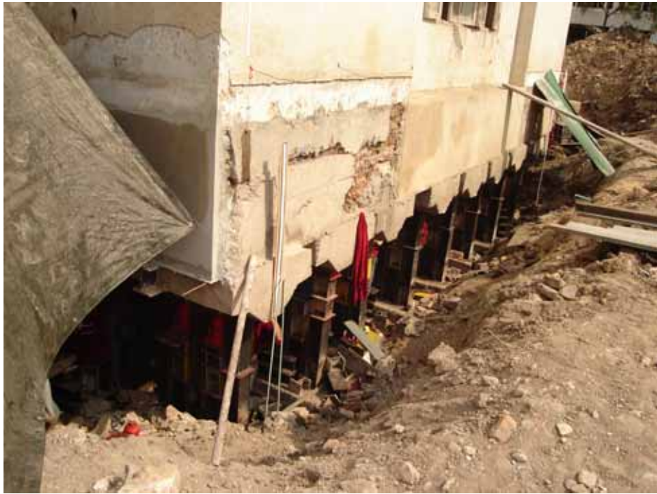
อาคารเมื่อยกเสร็จแล้วสูงขึ้นจากเดิม 1.25 ม.
