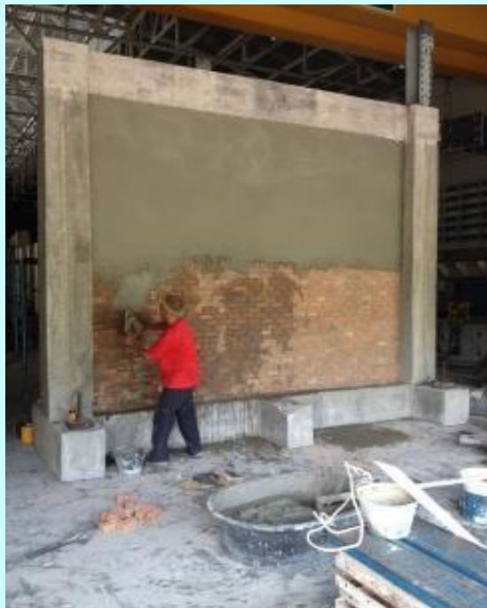
ผนังก่ออิฐมวลเบาในโครงเฟรมคอนกรีตเสริมเหล็ก (W1)
