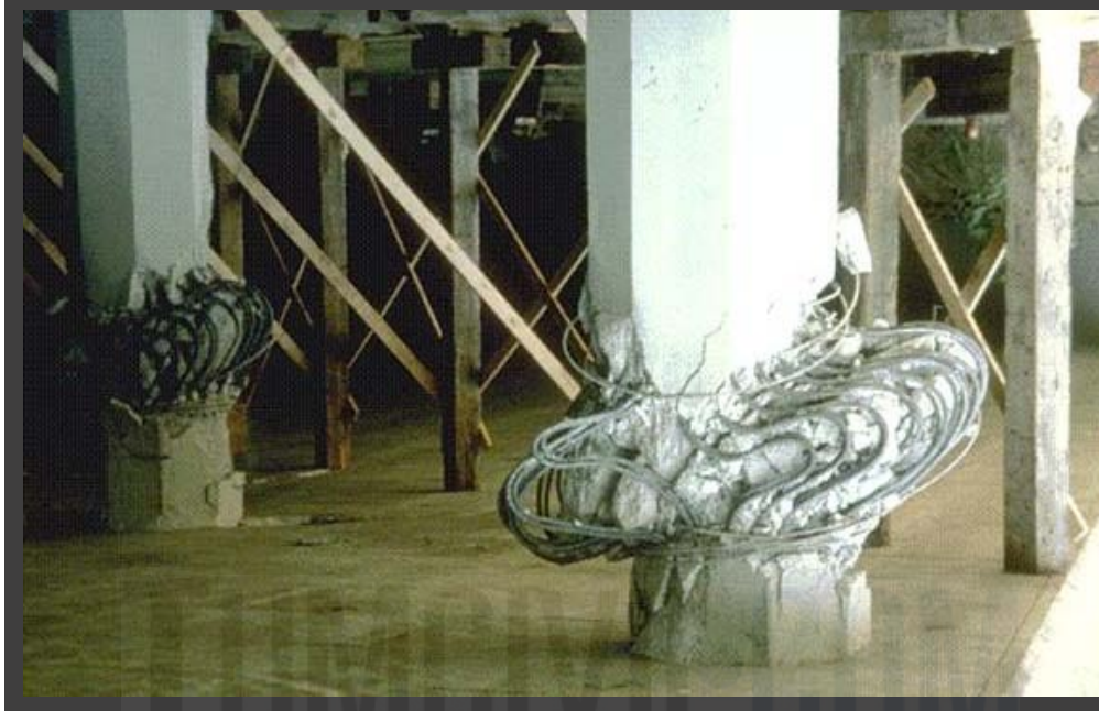
รูปที่ 2 การวิบัติของเสาคอนกรีตเสริมเหล็ก
