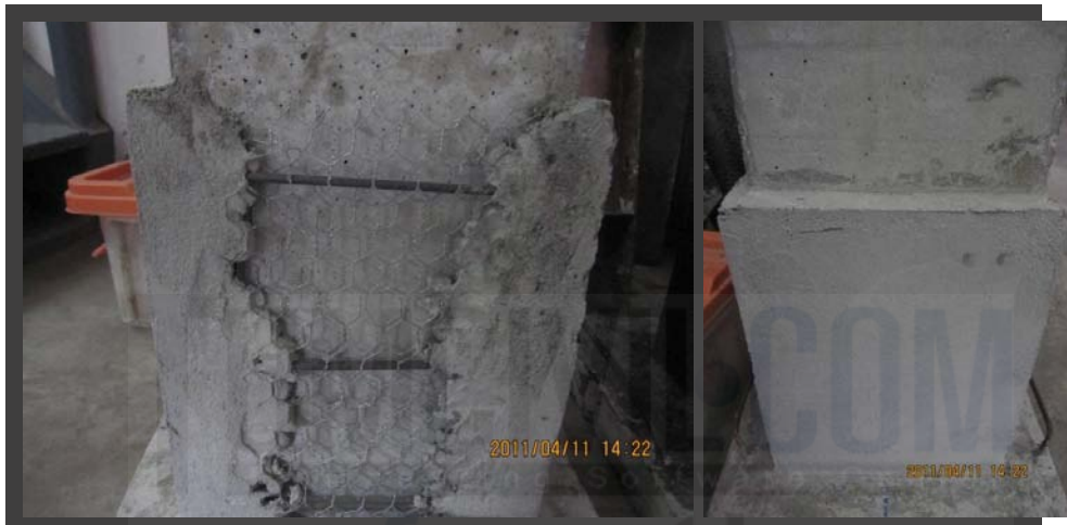
รูปที่ 7 เสาที่หุ้มด้วยแจ็กเก็ตแล้ว
