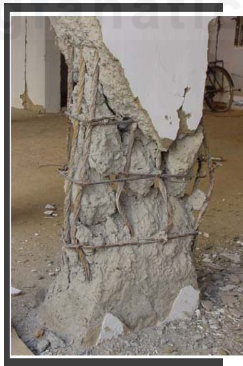
รูปที่ 1 การวิบัติของเสาคอนกรีตเสริมเหล็ก
