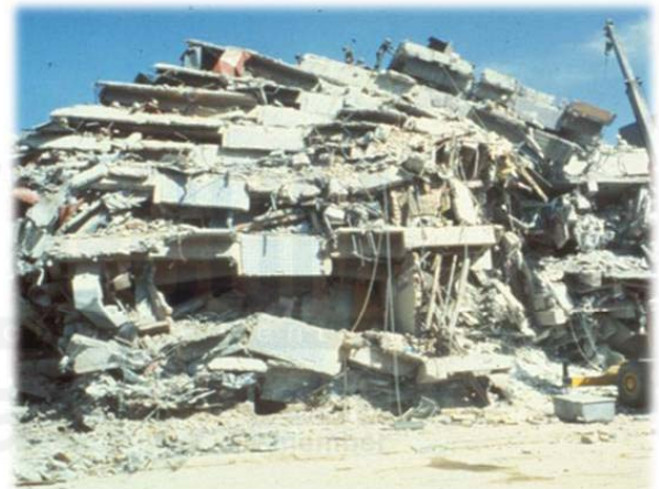
รูป 1 ตัวอย่างการวิบัติของอาคารในลักษณะ progressive ที่ประเทศเม็กซิโก
