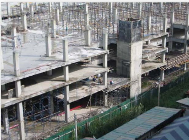
รูปที่ 1 โครงสร้างอาคารที่ประกอบด้วยโครงข้อแข็งและกำแพงเฉือน
