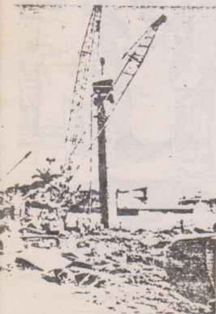
การถอนปลอกเหล็กโดยใช้ Vibro-Hammer
