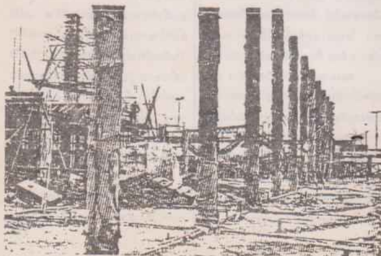
การบ่มคอนกรีตเสา
