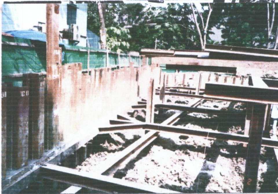
รูปที่ 15 การติดตั้ง Bracing ชั้นแรกหลังจากขุดดิน
