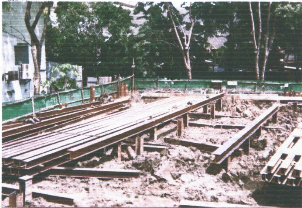
รูปที่ 10 ติดตั้งคานสะพาน
