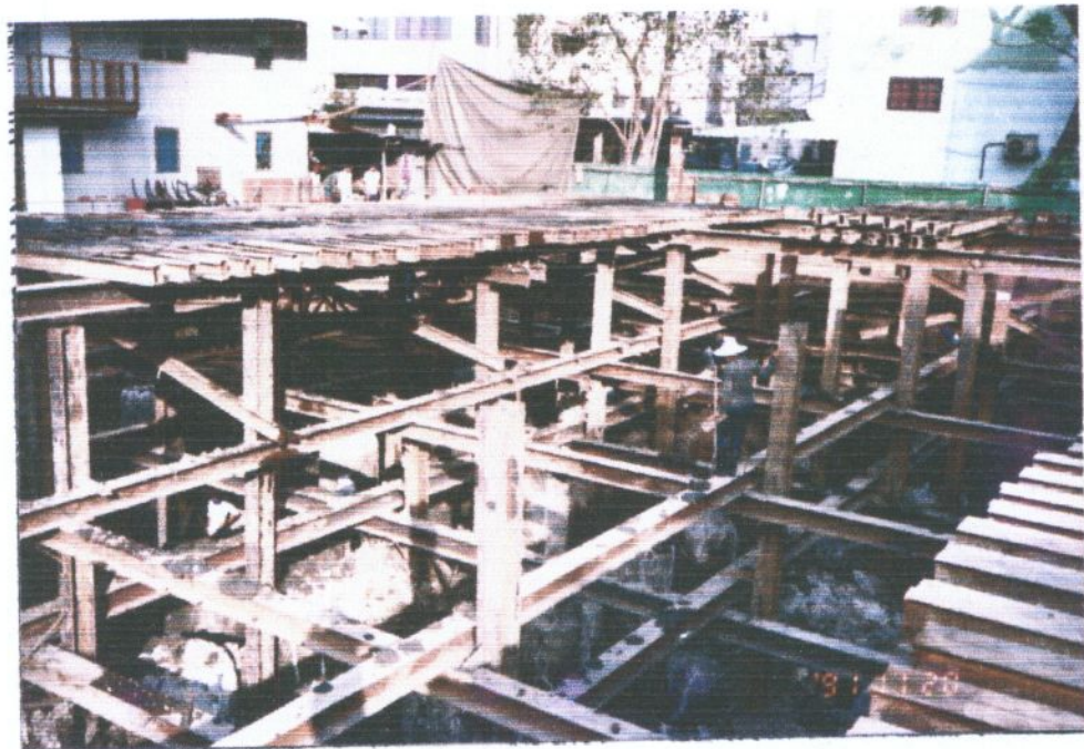
รูปที่ 5 ติดตั้ง BRACING ชั้นที่ 2
