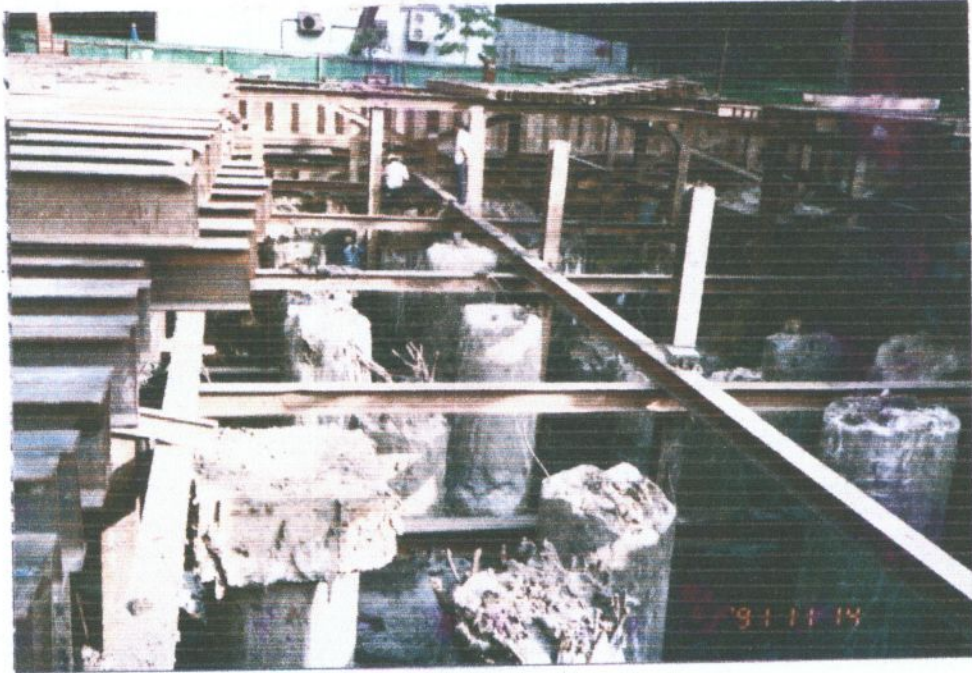
รูปที่ 4 เริ่มขุดดินชั้นที่ 2 ระดับความลึก - 3.05 เมตร
