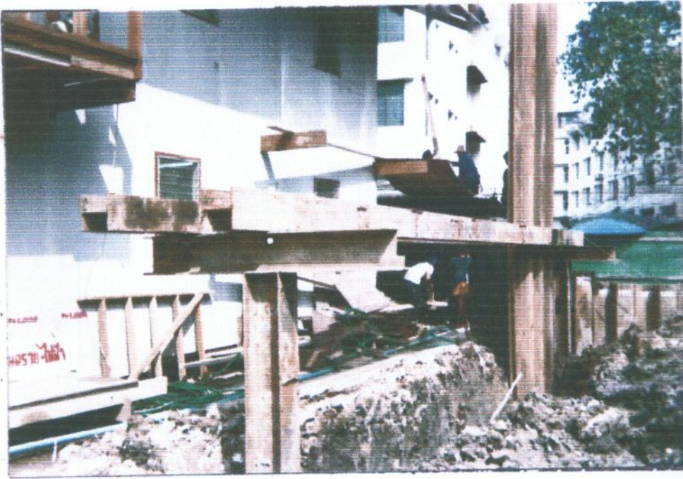
รูปที่ 6 การวาง Guide Line ที่ 1
