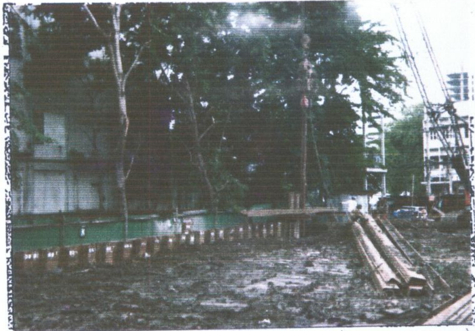
รูปที่ 7 การกด Sheet Pile ที่ Guide Line 6
