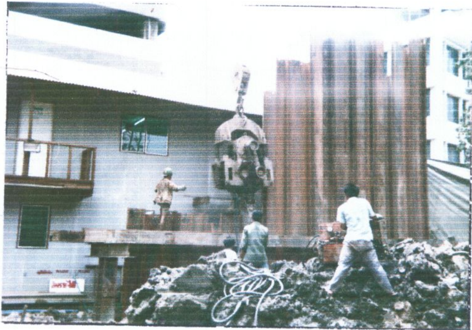
รูปที่ 15 กัด SHEET PILE ด้านทิศตะวันตก
