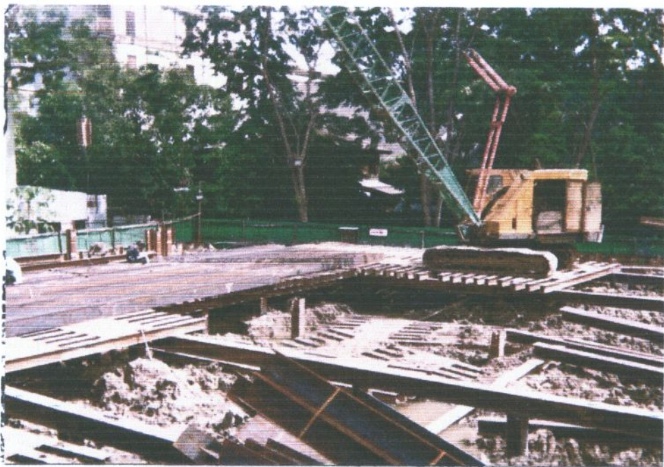
รูปที่ 11 แสดงการติดตั้งคานสะพานและประกอบชุดสะพาน
