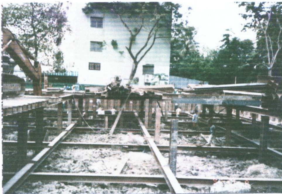
รูปที่ 3 ติดตั้ง BRACING ชั้นแรก
