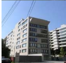
อาคารอยู่อาศัยรวม
