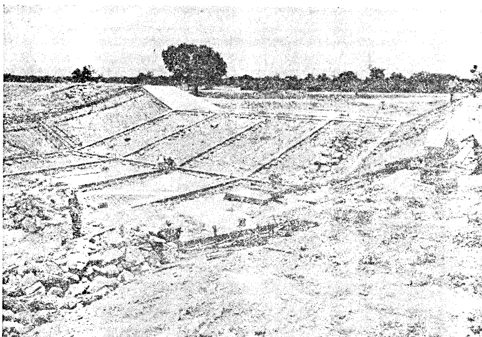
รูปที่ 10.2 งานก่อสร้างทางระบายน้ำดินแบบรางเท
