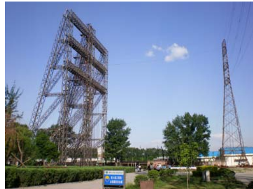
Tower และ Rigging Structure
