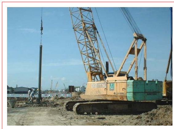
ติดตั้งท่อสำหรับเทคอนกรีต หรือ Tremie Pipe ลงไปถึงก้นหลุม
