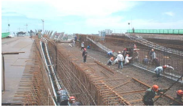
ติดตั้งเหล็กเสริมของพื้นด้านล่างและผนังพร้อมติดตั้งท่อสำหรับลวดอัดแรง Post-tension Tendon
