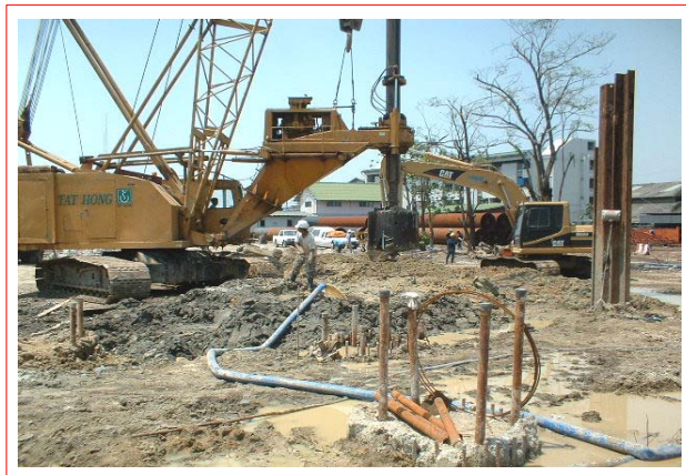
ดำเนินการขุดเจาะดินด้วยหัวเจาะแบบ Bucket ลงไปจนถึงระดับปลายเสาเข็มที่กำหนด ทั้งนี้ต้องจมอยู่ในชั้นทรายชั้นที่สามไม่น้อยกว่า 1.00 เมตร
