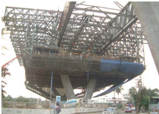
เทคอนกรีต Top Slab และดึงลวดอัดแรงส่วนที่เหลือเมื่อคอนกรีตได้อายุ จึงถอดแบบ External Formwork โดยการลดระดับลง และถอด Tie Bar ออก แยก Transverse Beam ส่วนที่รองรับ External Formwork ออกจากกันจนพื้นระยหะความกว้างเสา เป็นตำแหน่งที่จะเคลื่อนไปด้านหน้ายังช่วงสะพานถัดไปเคลื่อน MSS ไปข้างหน้า โดยใช้ระบบ Launching ขับเคลื่อนไปยังตำแหน่งเสาถัดไปซึ่งได้ก่อสร้างคานขวาง Cross beam ไว้ล่วงหน้าแล้ว จึงเริ่มประกอบ External Formwork และเตรียมก่อสร้างตามขั้นตอนเดิมต่อไป
