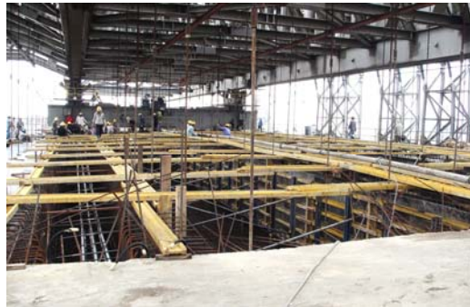
ติดตั้งเหล็กเสริมของพื้นด้านล่างและผนังพร้อมติดตั้งท่อสำหรับลวดอัดแรง Post-tension Tendon
