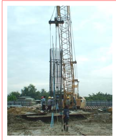
ติดตั้งเหล็กเสริมแต่ละท่อน (Reinforcement Steel Cages) ลงในหลุมเจาะ
