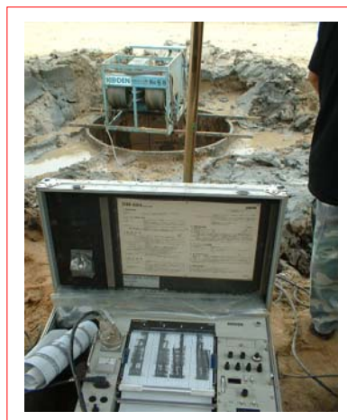
ตรวจสอบขนาดและแนวของหลุมเจาะ โดยวิธี Sonic Caliper Measurement แสดงค่าขนาดความกว้างและแนวของผนังหลุมเจาะ ตลอดความยาวหลุมเจาะ
