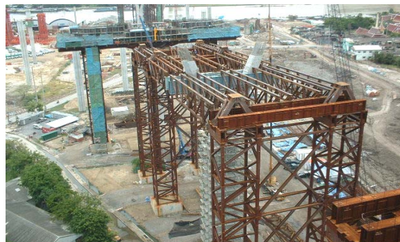
ก่อสร้าง Side Piers และ Temporary Props จากนั้นก่อสร้าง Pier Head บน Side Pier ด้านนอกทั้งสองฝั่ง
