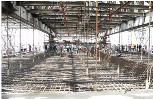
ติดตั้งแบบ Internal Formwork สำหรับ Top Slab แล้วติดตั้งเหล็กเสริมและลวดอัดแรงใน Top Slab
