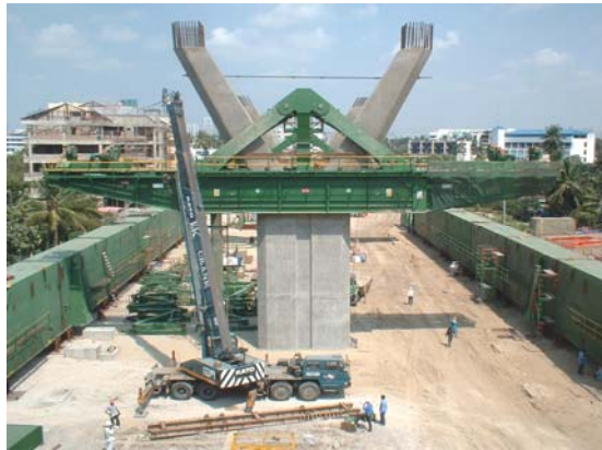
Supporting Bracket ทำหน้าที่ รองรับน้ำหนักจาก Main Girder
