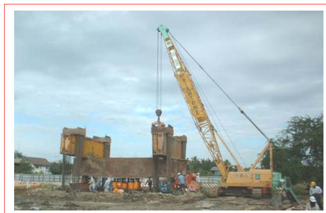
Test Pile เพื่อกำหนดความลึกของเสาเข็มเจาะ
