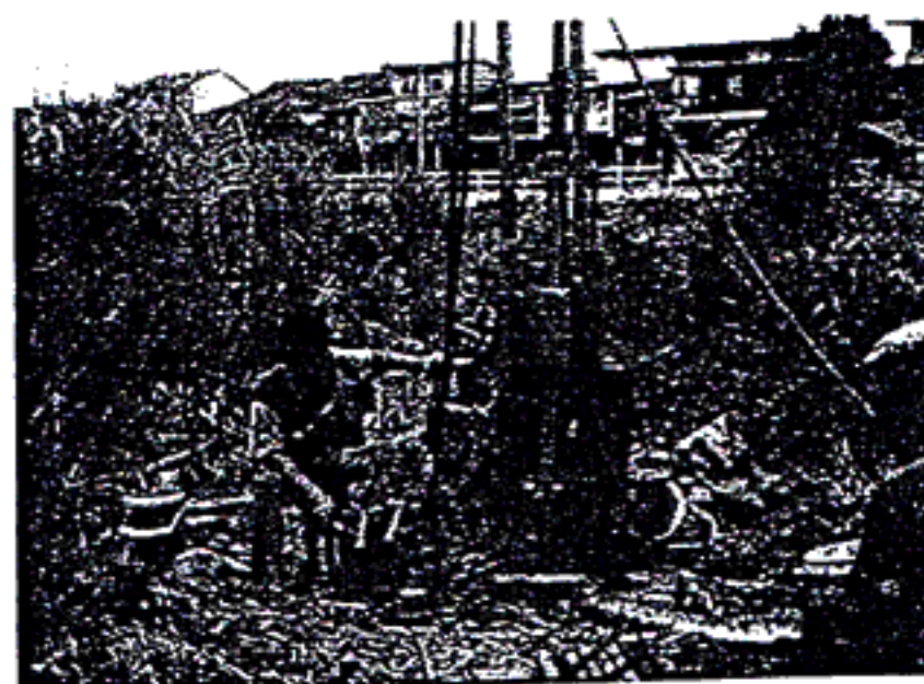
รูปที่ 10 การเจาะสำรวจด้วย Rotary Drilling
