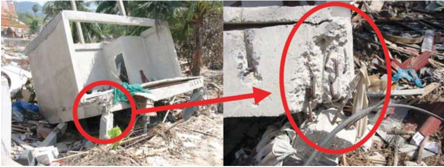
รูปที่ 17 ความเสียหายที่เกิดขึ้นที่จุดต่อ (หาดกมลา จ. ภูเก็ต)
