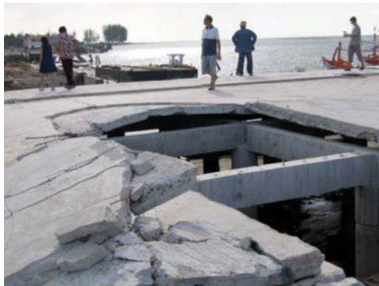
รูปที่ 10 แผ่นพื้นสำเร็จรูปที่ถูกสึนามิดันให้หลุดจากคาน
