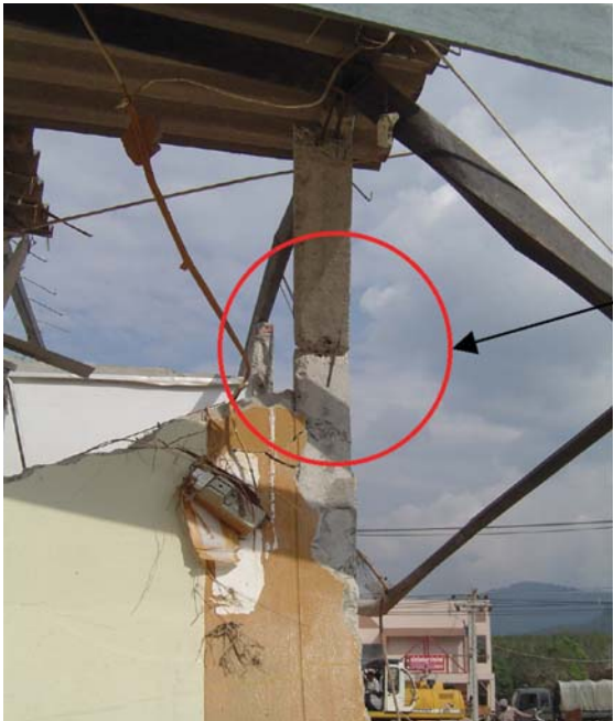
รูปที่ 21 ตัวอย่างรอยต่อที่ไม่เป็นเนื้อเดียวกันจากการก่อสร้างที่ไม่ได้มาตรฐาน
