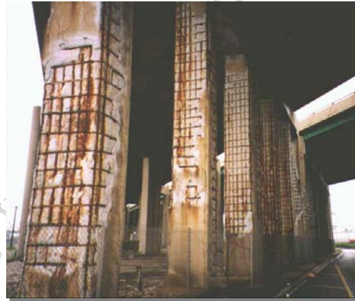
รูปที่ 1 แสดงการเป็นสนิมของเหล็กเสริมและการหลุดร่อนของคอนกรีต
