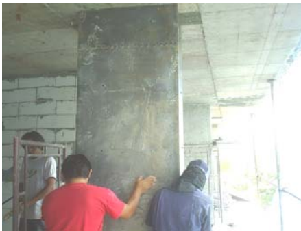
รูปที่11 การประกอบแผ่นเหล็กให้เรียบร้อยแล้วเชื่อมปิด
