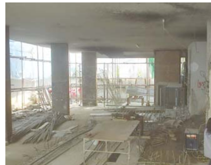
รูปที่12 เสาที่ได้รับการประกอบแผ่นเหล็กแล้ว
