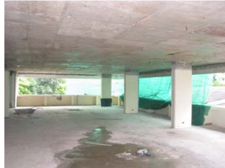
รูปที่2 สภาพอาคารเก่าบริเวณพื้นชั้นบน
