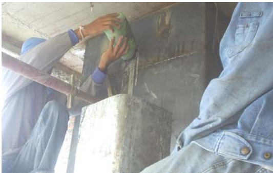
รูปที่13 การเติมปูนชนิดพิเศษในช่องว่างแผ่นเหล็กกับเสา
