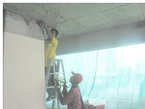
รูปที่4 การเจาะคอนกรีตเพื่อนำไปทดสอบกำลังอัด
