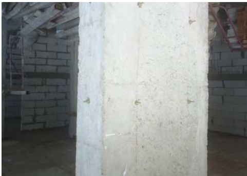
รูปที่9 เสาที่สกัดปูนฉาบออกและฝังสลักเกลียวแล้ว
