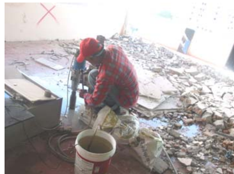
รูปที่4 การเจาะคอนกรีตเพื่อนำไปทดสอบกำลังอัด
