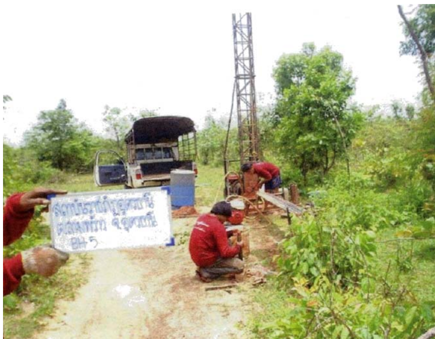
รูปที่ 1.21 การเจาะทดสอบดิน โดยวิธีการฉีดล้าง
