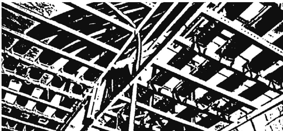
สายเคเบิลต้องมัดเข้ากับรางเคเบิล
